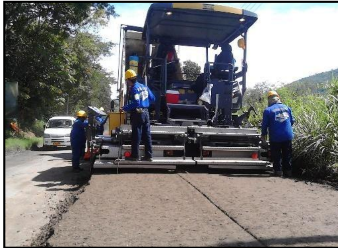
INSTALACIÓN BASE K2+740
