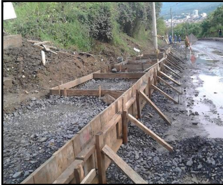
CONFORMACION DE ANDEN K0+900
