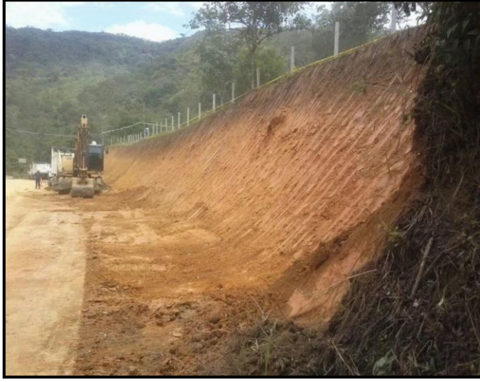
AMPLIACIÓN VÍA CORTE DE TALUD K27+000
