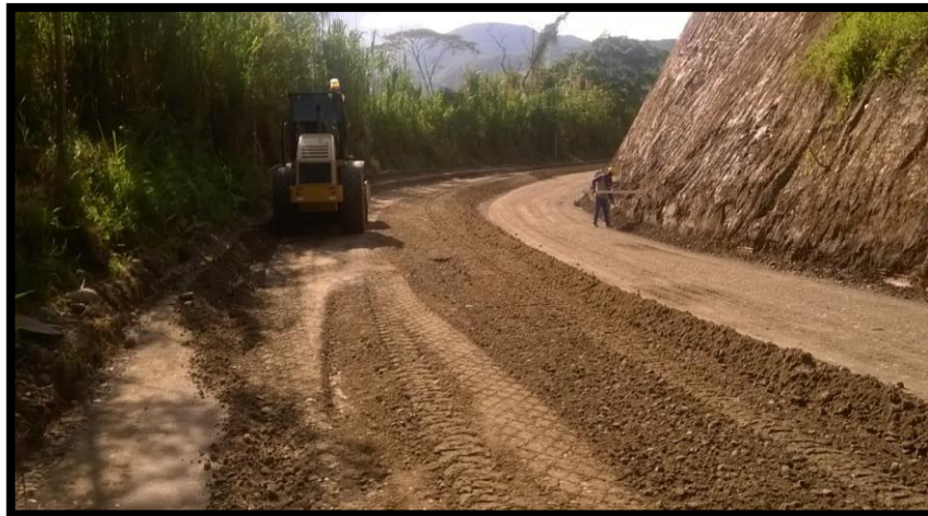
COMPACTACION SUB-BASE K27+500
