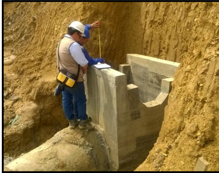
CABEZOTE ALCANTARILLA K27+740
