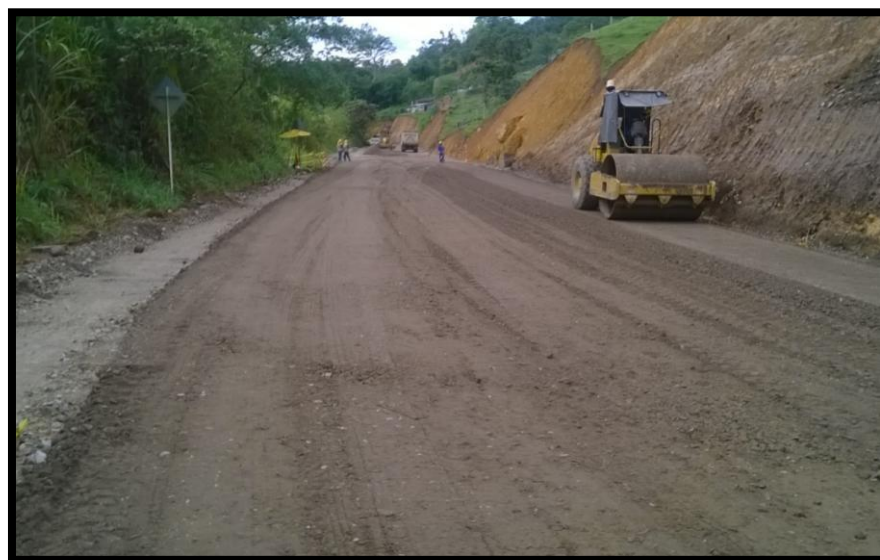
COMPACTACIÓN BASE GRANULAR K27+500
