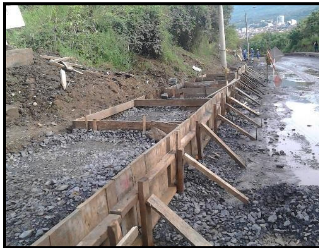
CONFORMACION DE ANDEN K0+900
