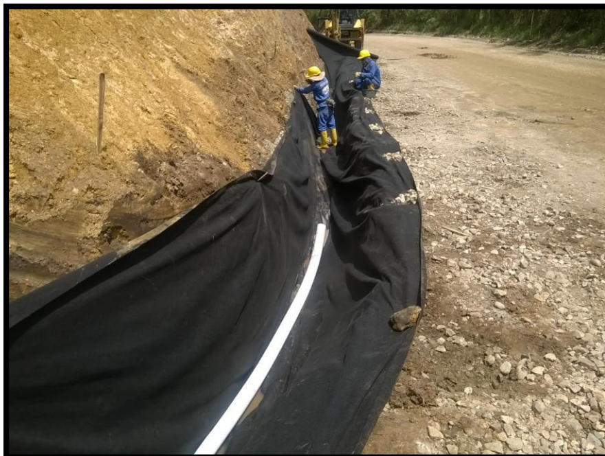
INSTALACIÓN GEOTEXTIL K27+700
