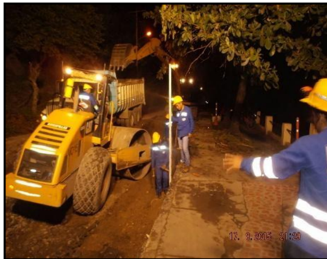
COMPACTACION MEJORAMIENTO K0+380
