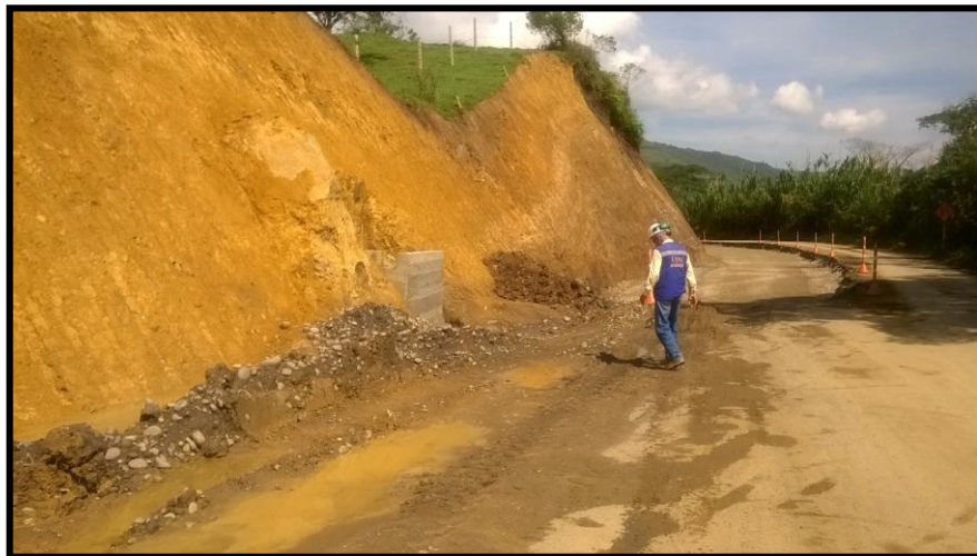
CONFORMACIÓN DE TALUDES K28+340
