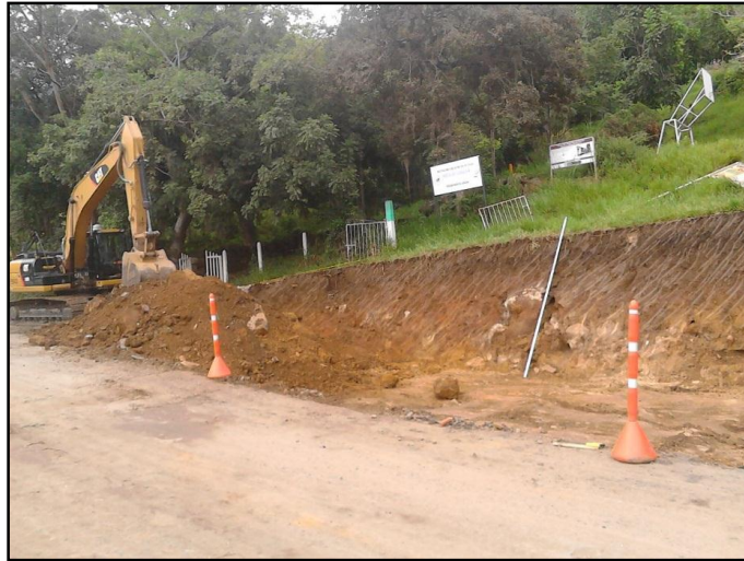
AMPLIACION DE VIA K4+300
