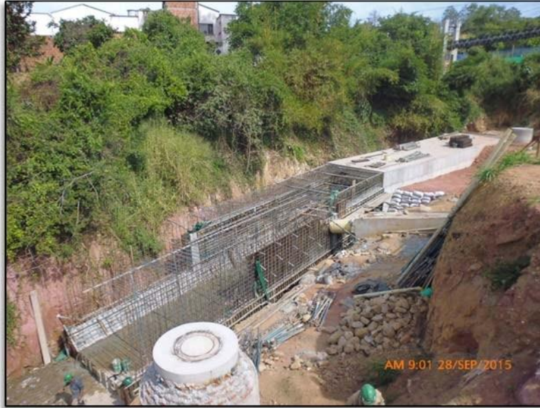
CONSTRUCCIÓN BOX COULVERT
