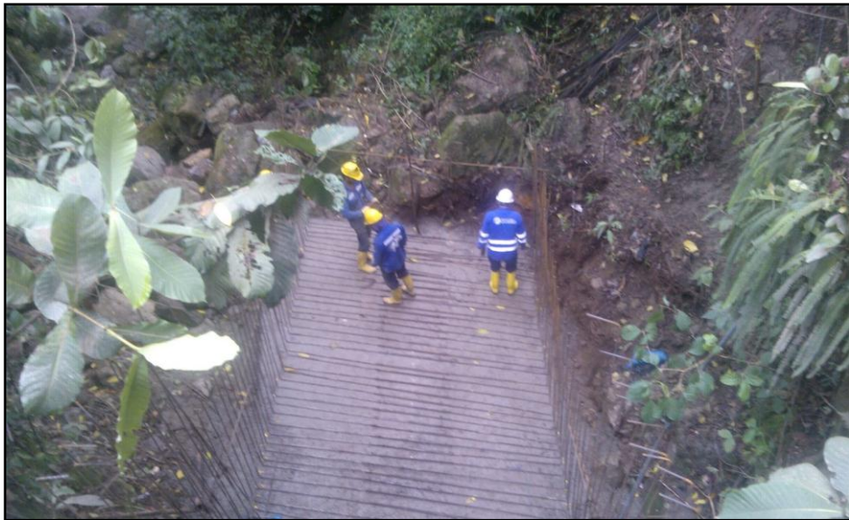
CONSTRUCCION BOX COULVERT K27+140
