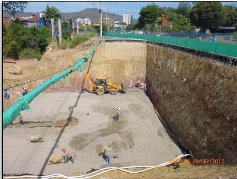
CONSTRUCCIÓN CAJA DEL DEPRIMIDO
