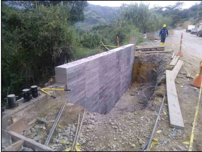
CONSTRUCCION MURO DE CONTENCIÓN K28+060
