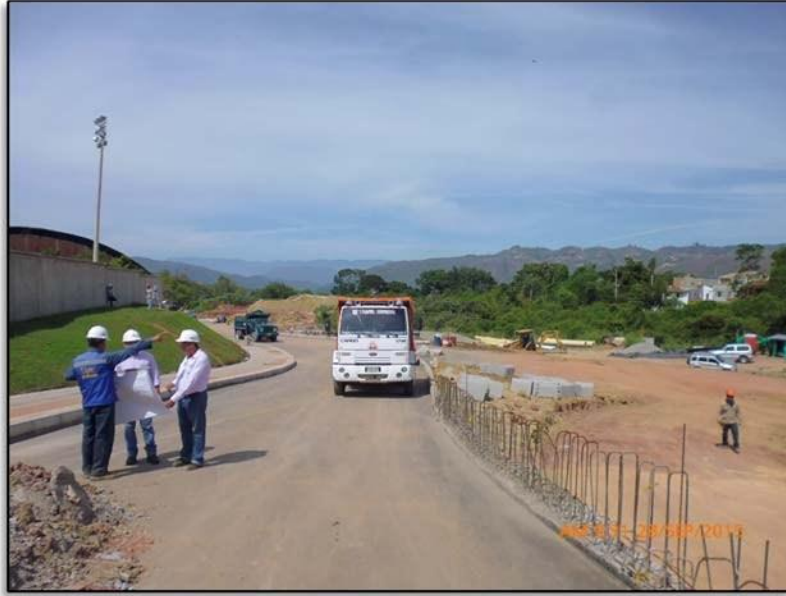
CONSTRUCCIÓN EJE No. 09.
