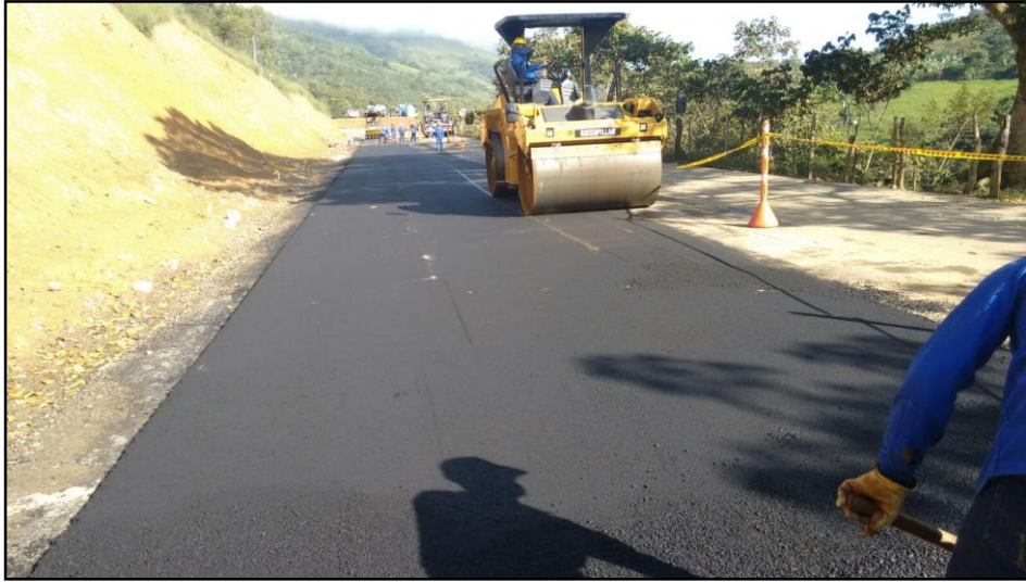
INSTALACIÓN BASE ASFALTICA PRIMERA CAPA K27+000
