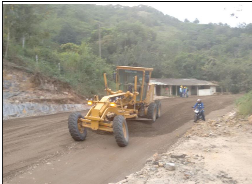
INSTALACIÓN BASE GRANULAR K27+000
