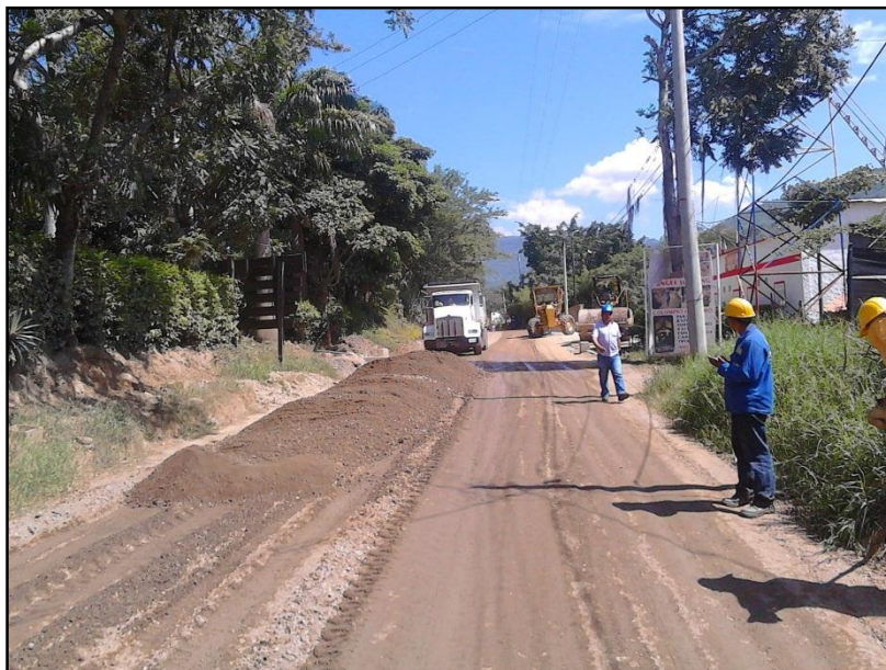
INSTALACIÓN BASE GRANULAR K2+800
