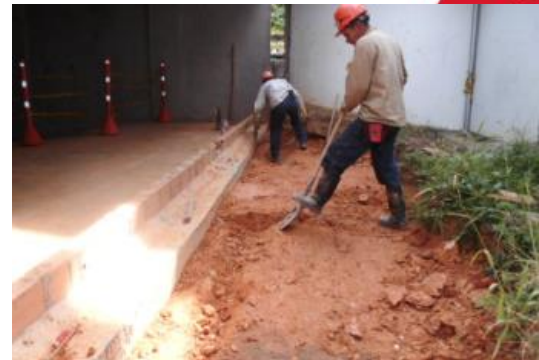
Excavación y fundida de cunetas
