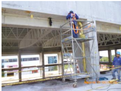
Instalación tubería de aguas lluvia
