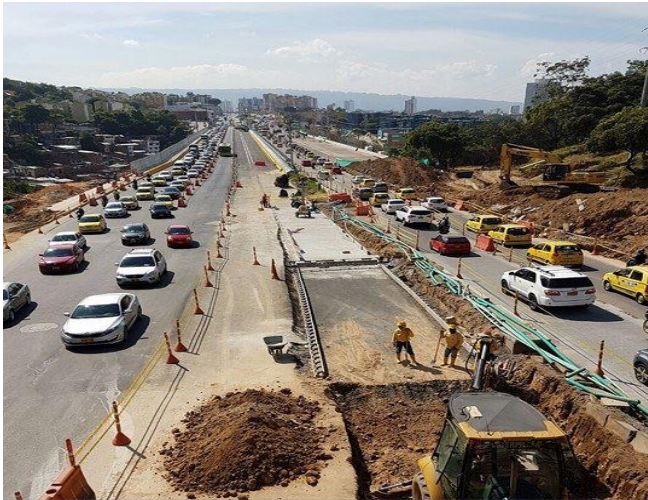
VIADUCTO LA UNION: Puesta en servicio 27 de noviembre. Viaducto García Cadena se pavimenta el 15 de diciembre.
