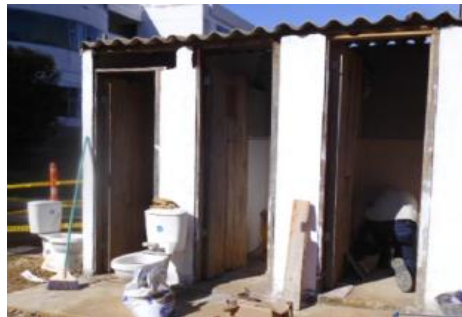
Instalación de baños para personal administrativo del contratista
