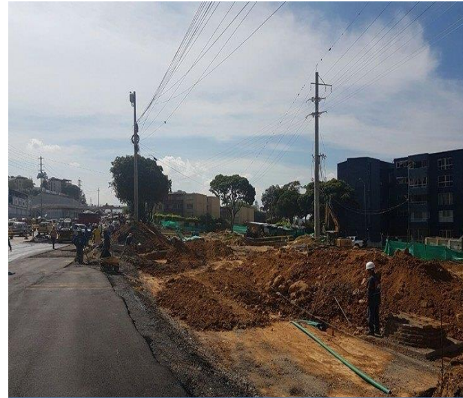
Zona de acceso deprimido el Diamante II
