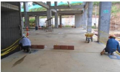
Replanteo de muros en mampostería
