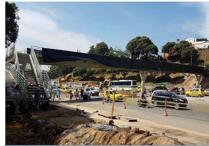
PUENTE PEATONAL ANTONIA SANTOS: Armado y ensamble de estructura 13 de Diciembre.
