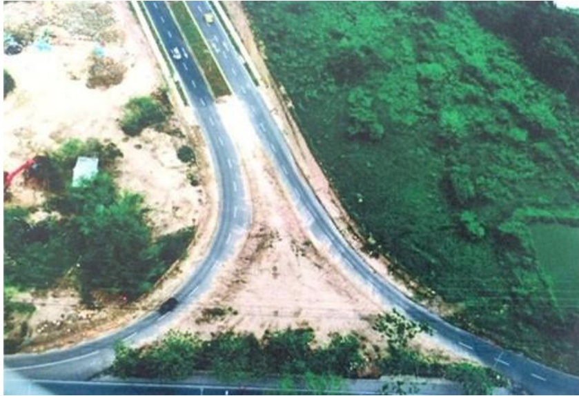
Estado actual - PR 3 + 000 Intersección Transversal del Bosque – Anillo Vial
