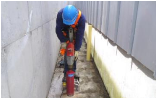
Extracción de núcleos en concreto de \varnothing=4'' y 6''
