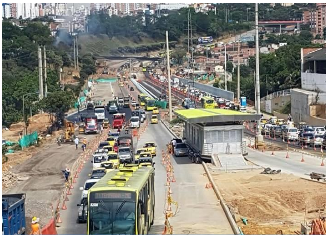
SECTOR OCCIDENTAL AUTOPISTA: Perfilado e instalación de base granular e inicio de pavimentación 13 de Diciembre
