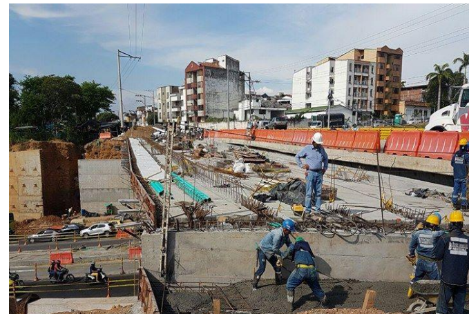
PUENTE CONUCOS SUR Y MUROS: Se fundió el tablero y losa de aproximación. Pendiente fundir muro Salle y relleno de muros.
