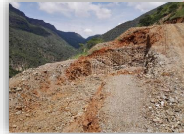
Replanteo y excavación de estación de bombeo No. 3
