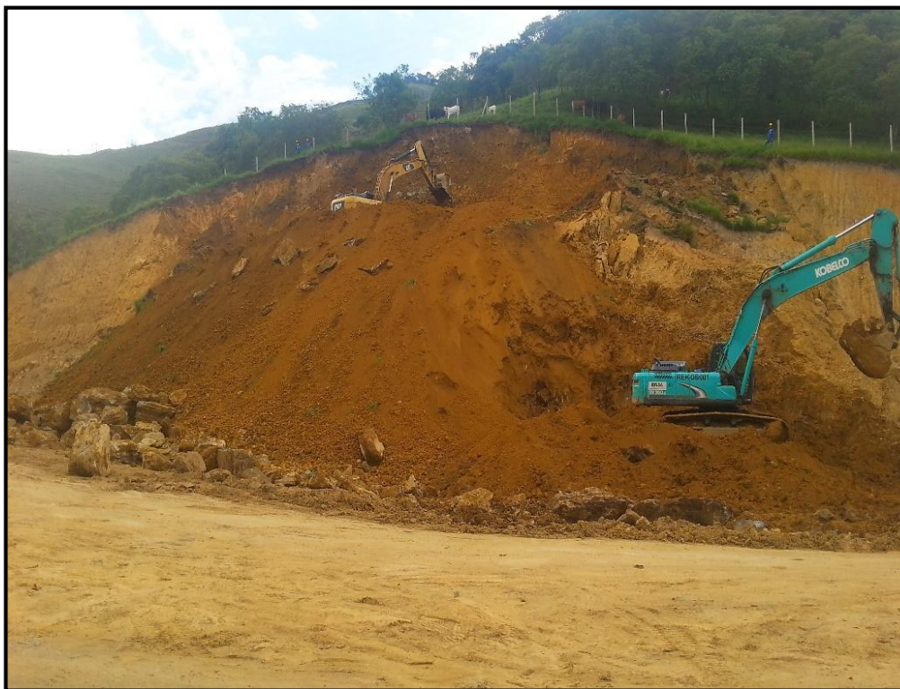
REMOCION DE DERRUMBRE K27+770
