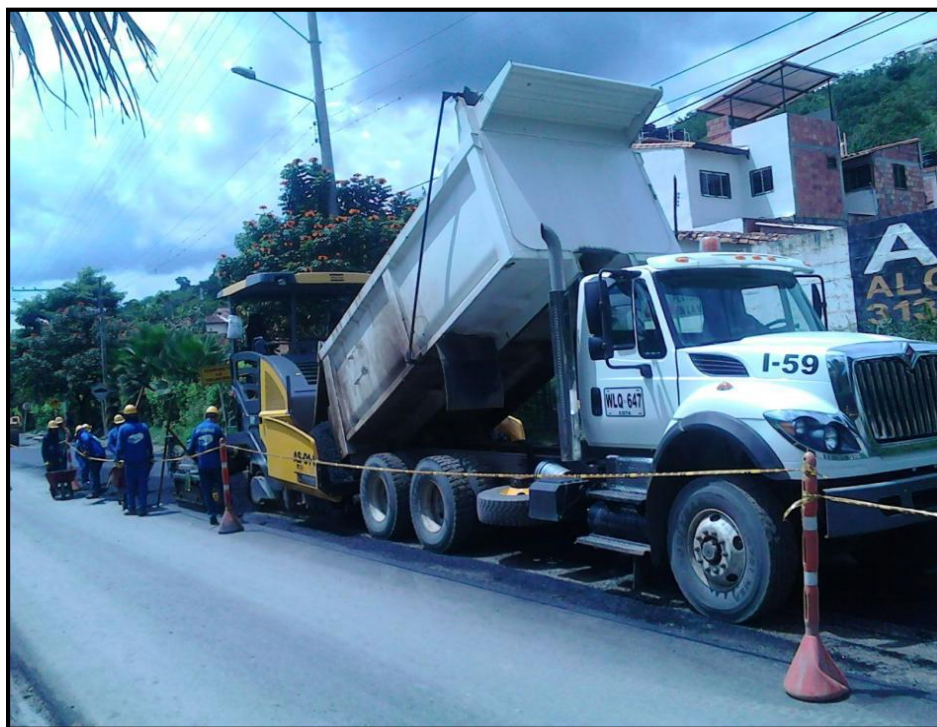
COLOCACIÓN CARPETA ASFALTICA PRIMERA CAPA MDC 2 K1+380
