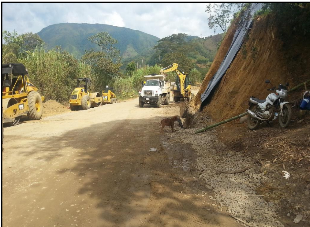
CONSTRUCCIÓN DE FILTROS K28+700
