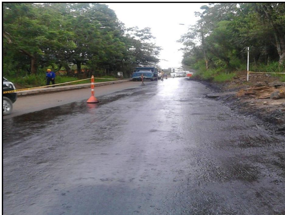
IMPRIMACIÓN CON EMULSIÓN ASFALTICA RR K1+140 A K1+270
