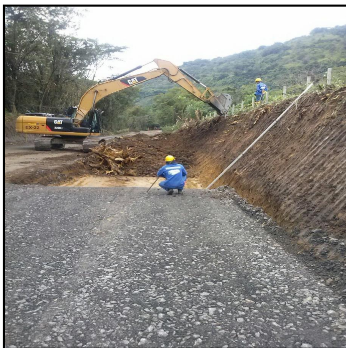
CAJA, TENDIDO DE TALUD Y MEJORAMIENTO K4+890
