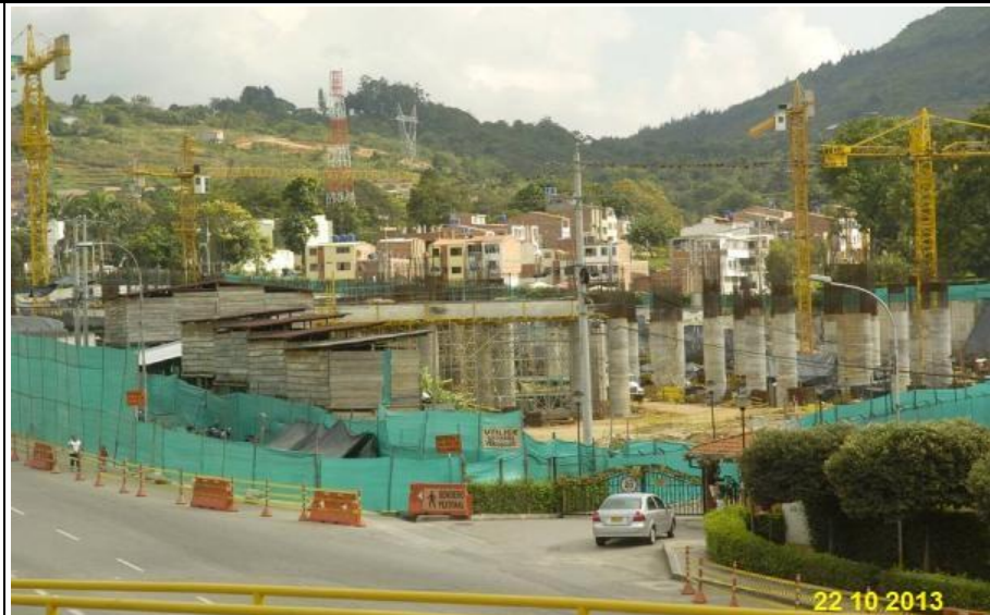
OBRAS SUSPENDIDAS DE PQP
