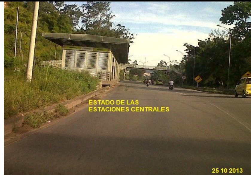
ESTADO DE ESTACIONES CENTRALES Y FALTA DE DEMARCAACION
