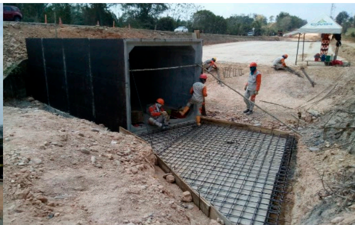
CONSTRUCCIÓN OBRAS DE DRENAJE – UF 2,3
