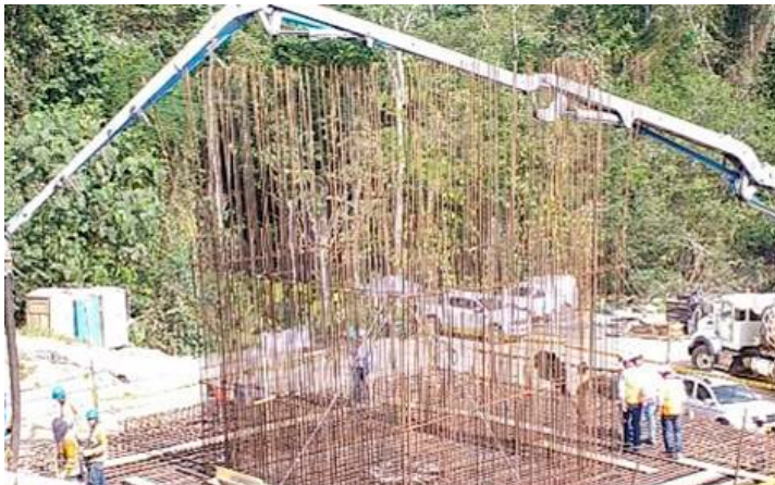
CONSTRUCCIÓN VIADUCTO LA PELIGROSA – UF 5
