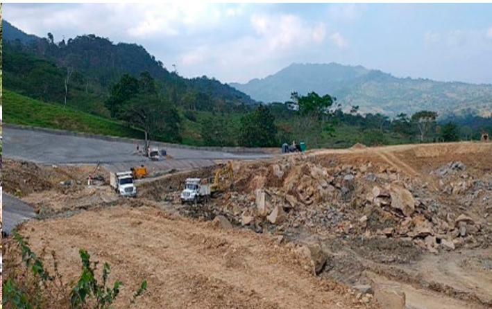
CONSTRUCCIÓN PORTAL SALIDA TÚNEL LA PAZ – UF 6
