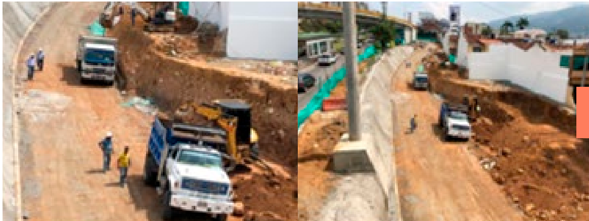
Conformación Talud Oriental
