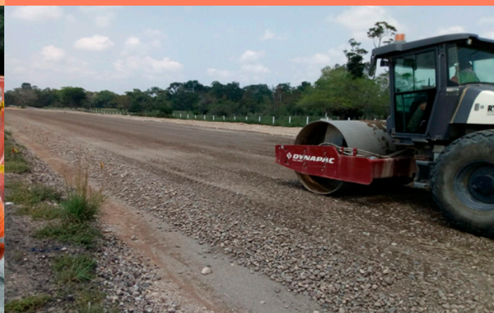
INSTALACIÓN Y COMPACTACIÓN DE SUB BASE – UF 4
