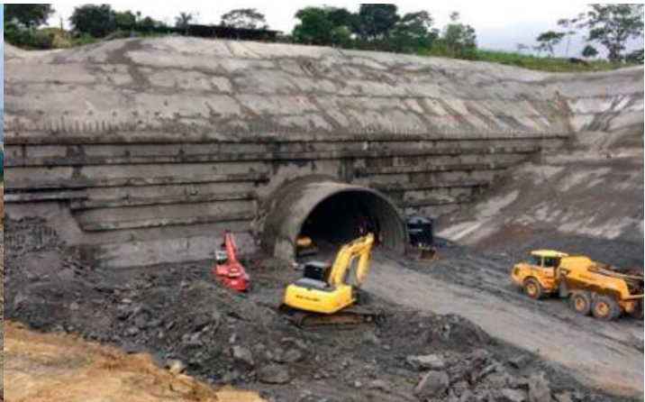
CONSTRUCCIÓN PORTAL ENTRADA TUNEL LA SORDA – UF 7
