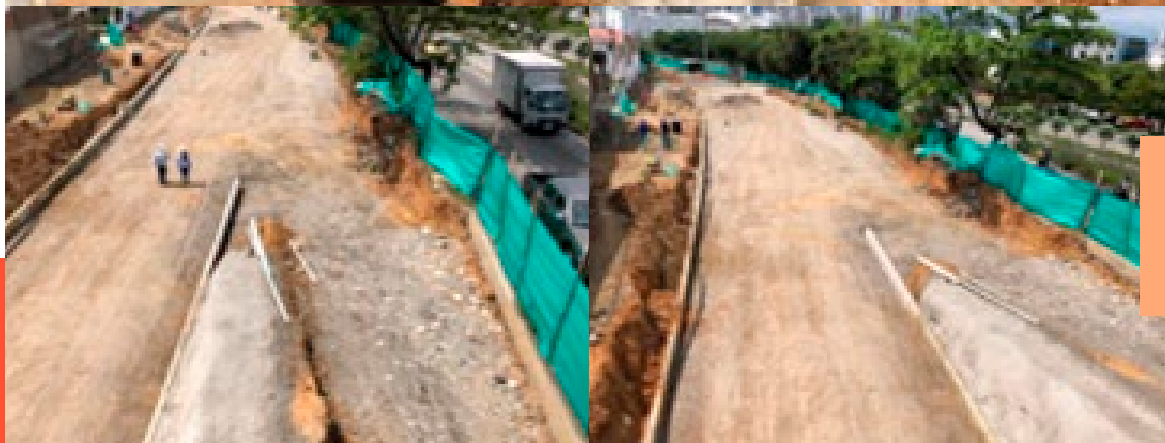
Conformación de la base de la vía. Bifurcación a la autopista
