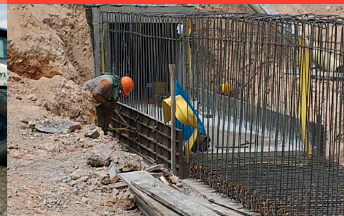
CONSTRUCCIÓN OBRAS DE DRENAJE TRANSVERSAL – UF 5
