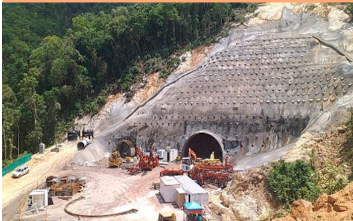
CONSTRUCCIÓN PORTAL ENTRADA TÚNEL LA PAZ – UF 6
