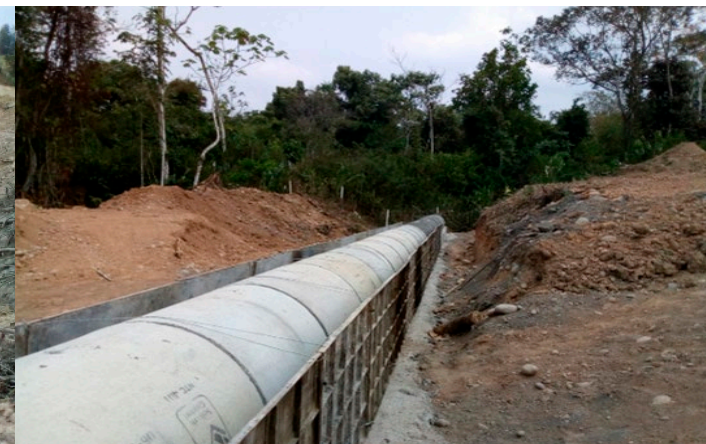
CONSTRUCCIÓN DE ALCANTARILLAS – UF 4
