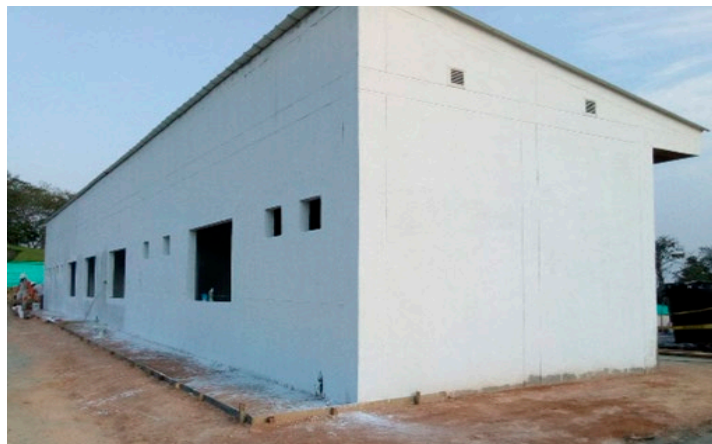
CONSTRUCCIÓN ESCUELA NUEVA BÉLGICA – UF 2,3
