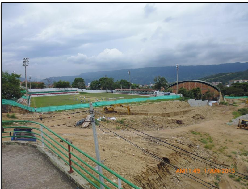
EXCAVACIONES PARA CONSTRUCCIÓN EJE No. 09
