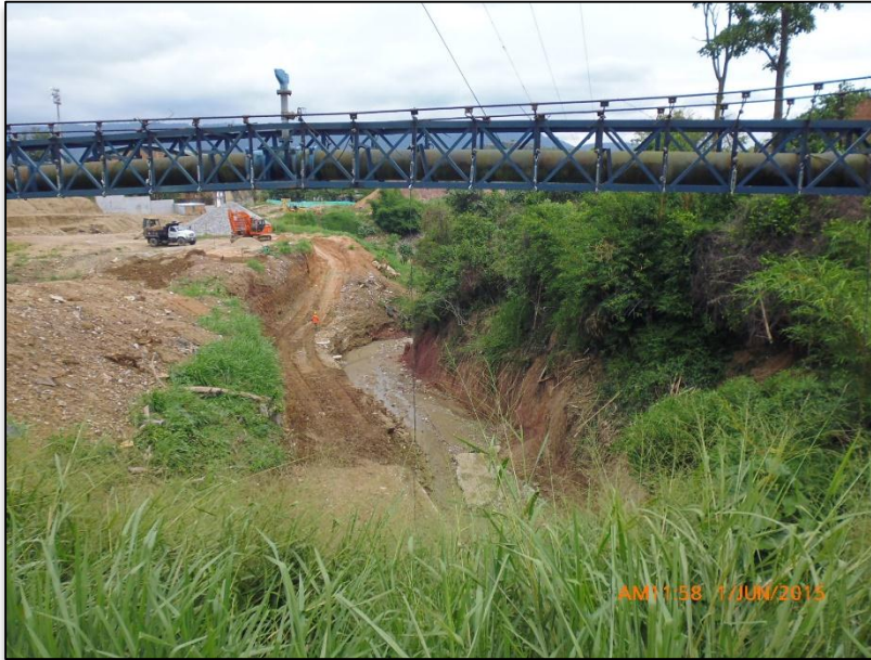
EXCAVACIONES CONSTRUCCIÓN BOX COULVERT – COSTADO OCCIDENTAL
