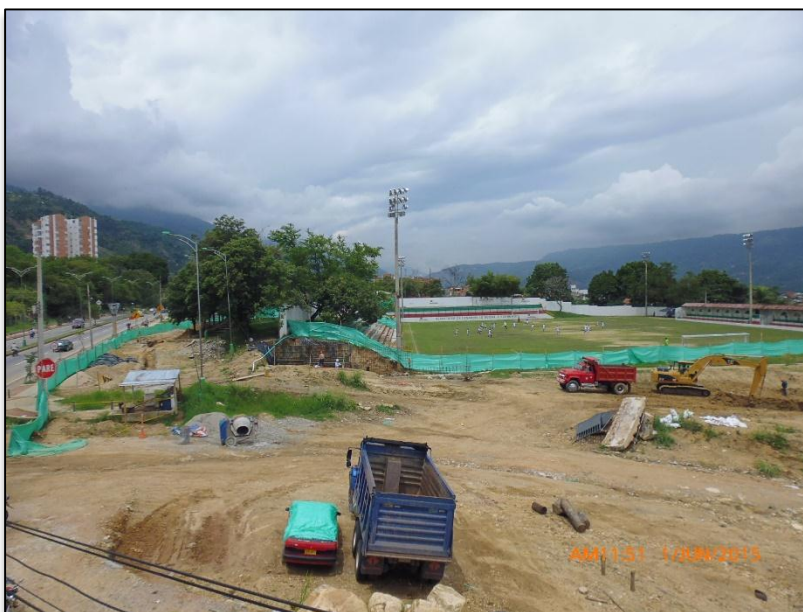
CONSTRUCCIÓN MURO ESTADIO VILLA CONCHA
