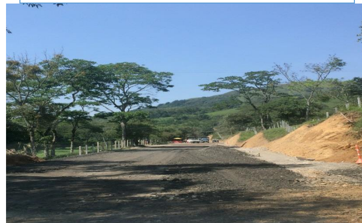
K31+110 APLICACIÓN DE SUBBASE
