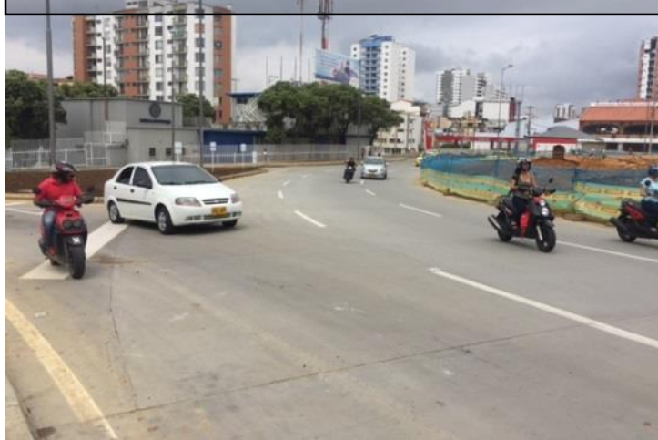
Eje N°1 Perimetral glorleta. Feb 22 17
