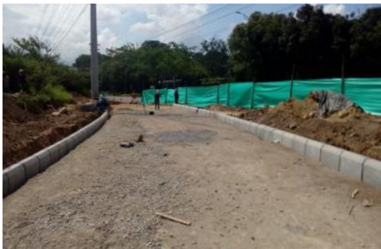
Base granular y colocación de sardineles del eje 5
