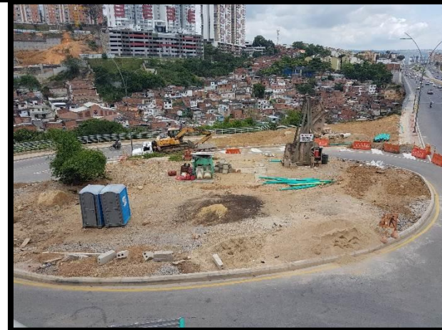
GLORIETA ENTRADA BARRIO ANTONIA SANTOS
