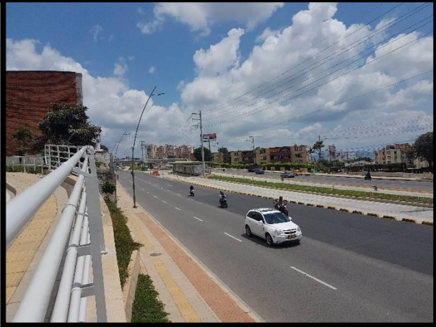
PANORAMICA ESTACION METROLINEA DIAMANTE II
