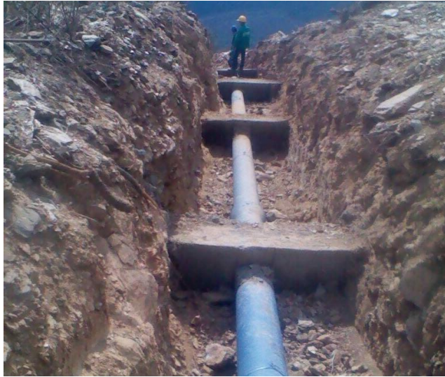
Instalación Tubería de Impulsión
