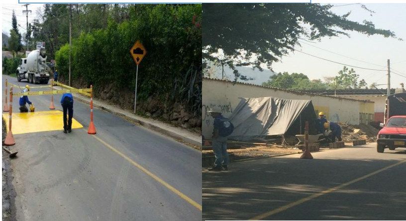
K0+630 REDUCTOR DE VELOCIDAD Y K1+000 INICIO ANDENES MI
