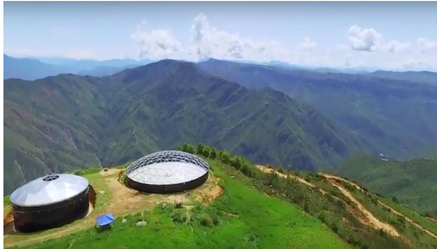
TANQUES DE ALMACENAMIENTO CONSTRUIDOS
