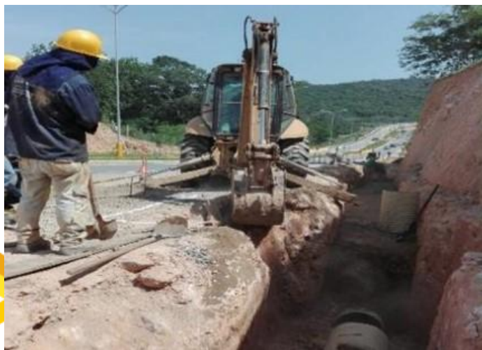
Excavación para construcción alcantarillado
