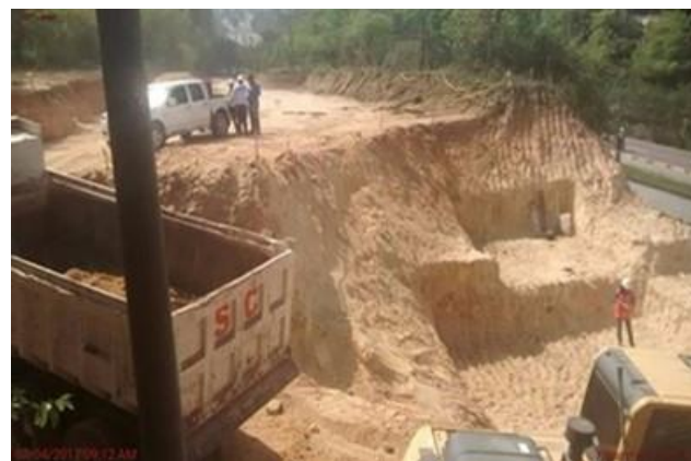
PREDIO 010 D FRISCO: Excavación Caja K0+530 a K0+770 y MURO CONTENCIÓN K0+770 - K0+804: movimiento de tierras y excavación cimentación muro. Cierre de vía Calle 35 Entrada Redil del Bosque, por plan de manejo de tráfico, con el respectivo permiso aprobado por la DTTF.
