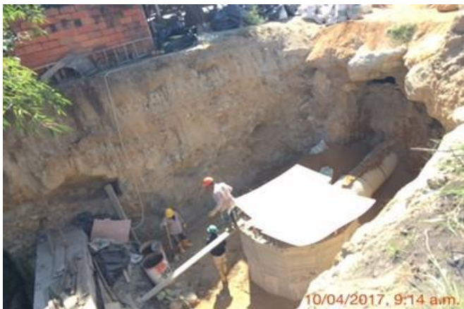
PREDIO 003 D – Ronda Río Frío. Construcción pozo inspección y avanza relleno descole tubería MARVAL- Río Frío. Actividades previas al inicio de trabajos de pilotaje apoyo estribo sur.
