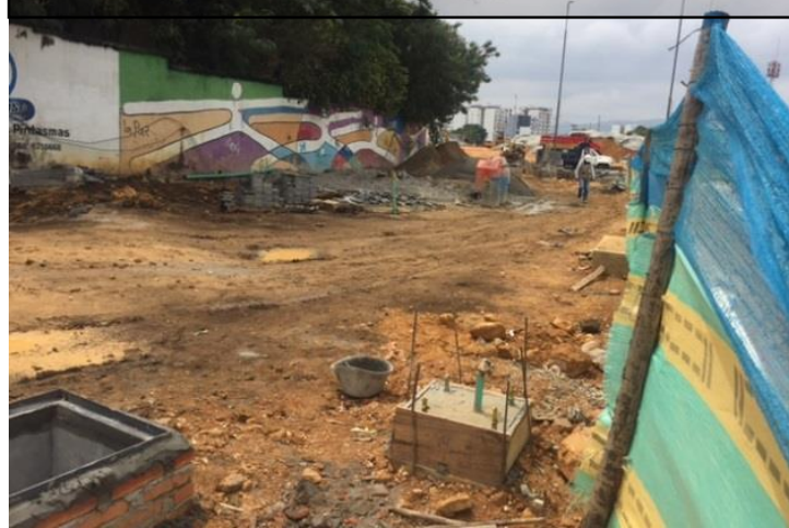
Eje N°2 Sin Intervenir Predio ESNB. Feb 22 17
