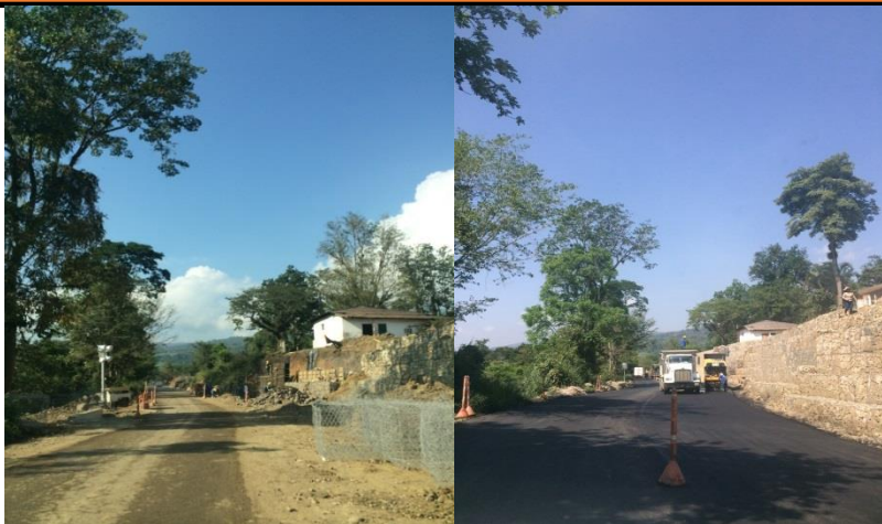
K13+450 ANTES Y DESPUES
