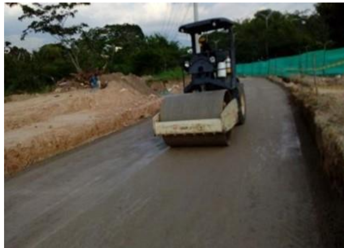
Compactación base granular Eje 5
