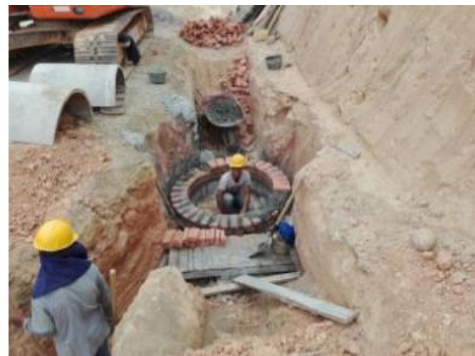
Construcción de pozo en mampostería MH5
