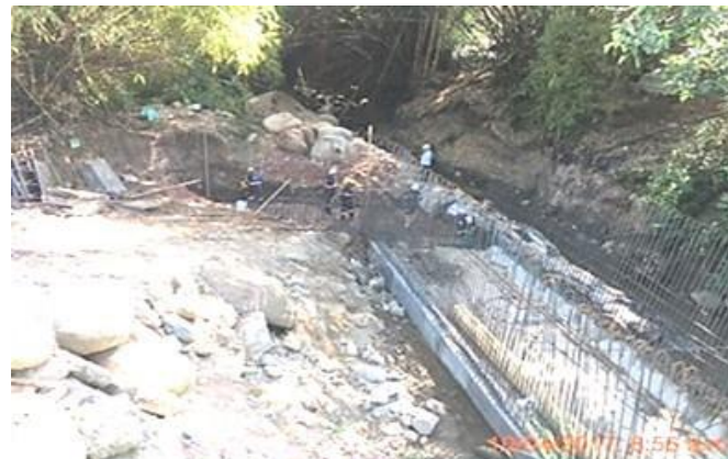
PREDIO 009 D - Ronda quebrada Suratoque - K0 +510 Proceso construcción Box Coulvert longitud = 17.70 m. En ejecución: placa fondo, aletas y dentellón.
