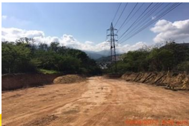
PREDIO 010 D FRISCO: Excavación Caja K0+530 a K0+770 y MURO CONTENCIÓN K0+770 - K0+804: movimiento de tierras y excavación cimentación muro. Cierre de vía Calle 35 Entrada Redil del Bosque, por plan de manejo de tráfico, con el respectivo permiso aprobado por la DTTF.
