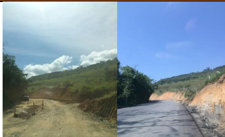
K16+980 ANTES Y DESPUES
