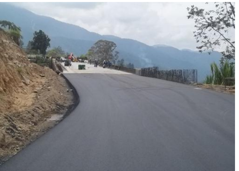
AVANCE EN LA CONSTRUCCION DE LOS EMPALMES ENTRE LOS VIADUCTOS Y LA VIA EXISTENTE
