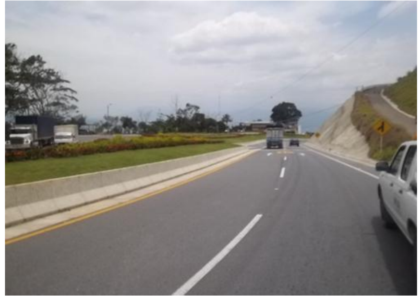
DOBLE CALZADA TERMINADA EN SERVICIO.
