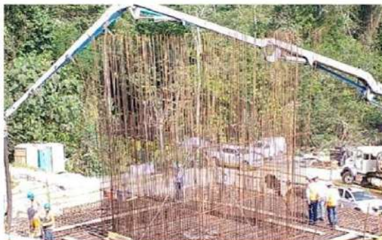
CONSTRUCCIÓN VIADUCTO LA PELIGROSA – UF 5
