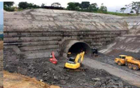
CONSTRUCCIÓN PORTAL ENTRADA TUNEL LA SORDA – UF 7
