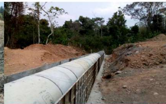
CONSTRUCCIÓN DE ALCANTARILLAS – UF 4
