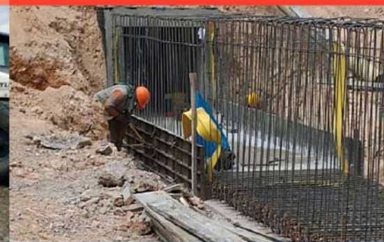
CONSTRUCCIÓN OBRAS DE DRENAJE TRANSVERSAL – UF 5
