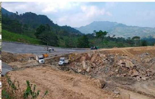
CONSTRUCCIÓN PORTAL SALIDA TÚNEL LA PAZ – UF 6
