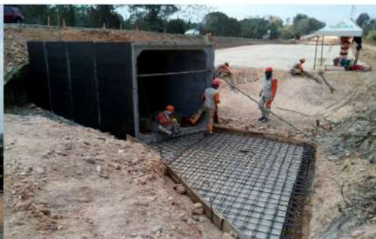
CONSTRUCCIÓN OBRAS DE DRENAJE – UF 2,3
