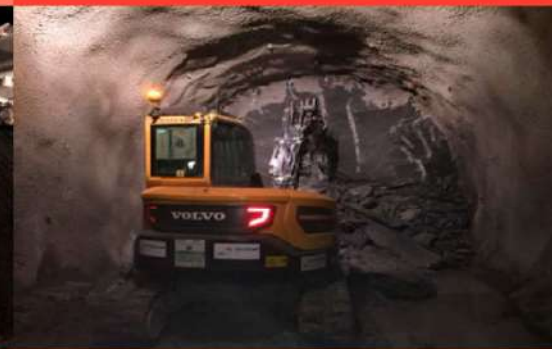
CONSTRUCCIÓN PORTAL SALIDA TÚNEL LA SORDA (GALERÍA) – UF 7
