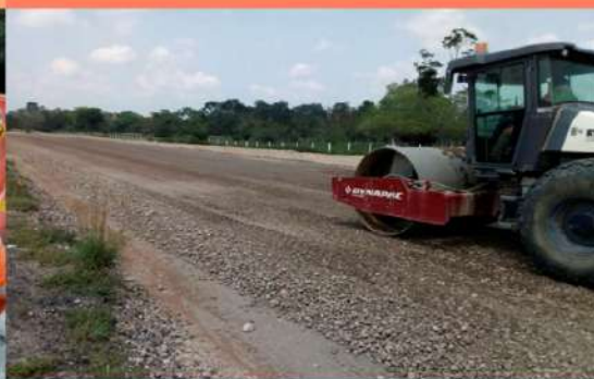
INSTALACIÓN Y COMPACTACIÓN DE SUB BASE – UF 4
