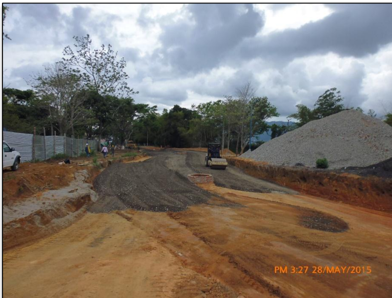
CONSTRUCCIÓN ESTRUCTURA DE LA CALZADA TRAMO FINAL EJE No. 02
