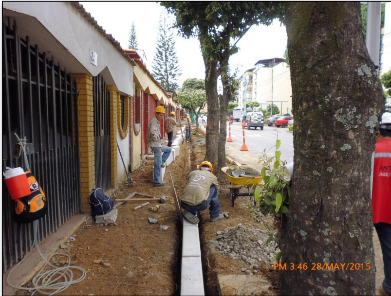
CONSTRUCCIÓN SENDEROS PEATONALES
