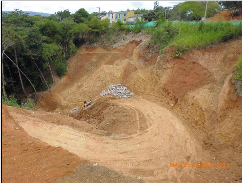
CONSTRUCCIÓN TALUD REFORZADO EJE No. 02
