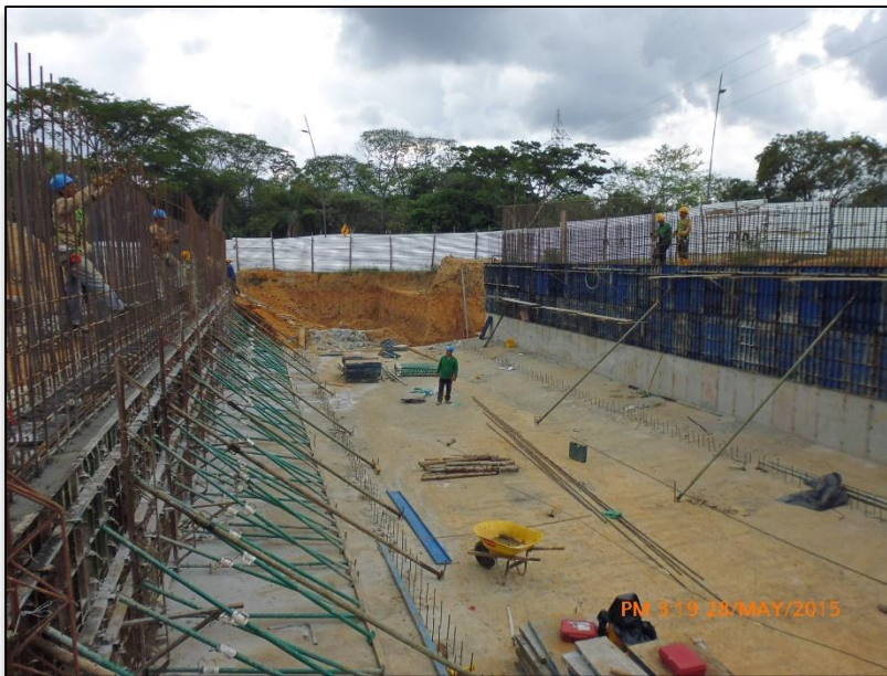
CONSTRUCCIÓN MUROS DEPRIMIDO EJE No. 03
