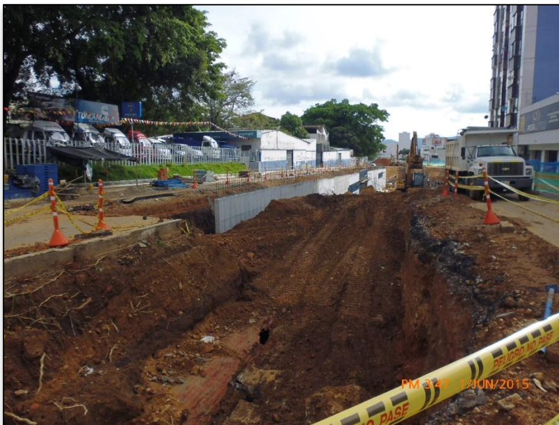
CONSTRUCCIÓN ACCESO AL DEPRIMIDO POR LA AVENIDA QUEBRADA SECA - ORIENTE
