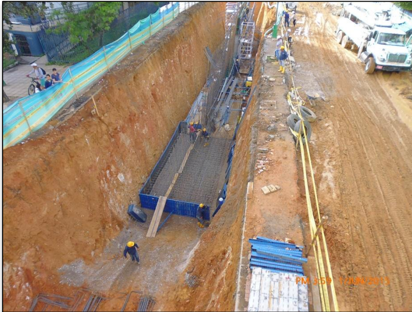
CONSTRUCCIÓN ACCESO AL DEPRIMIDO POR LA CARRERA 27 -SUR
