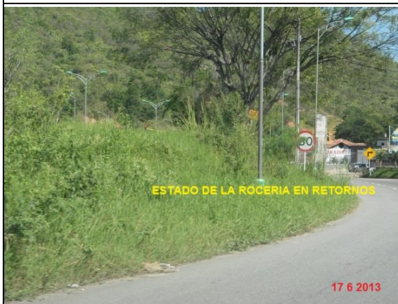
Figura 2 Corredor autopista Floridablanca Piedecuesta.
