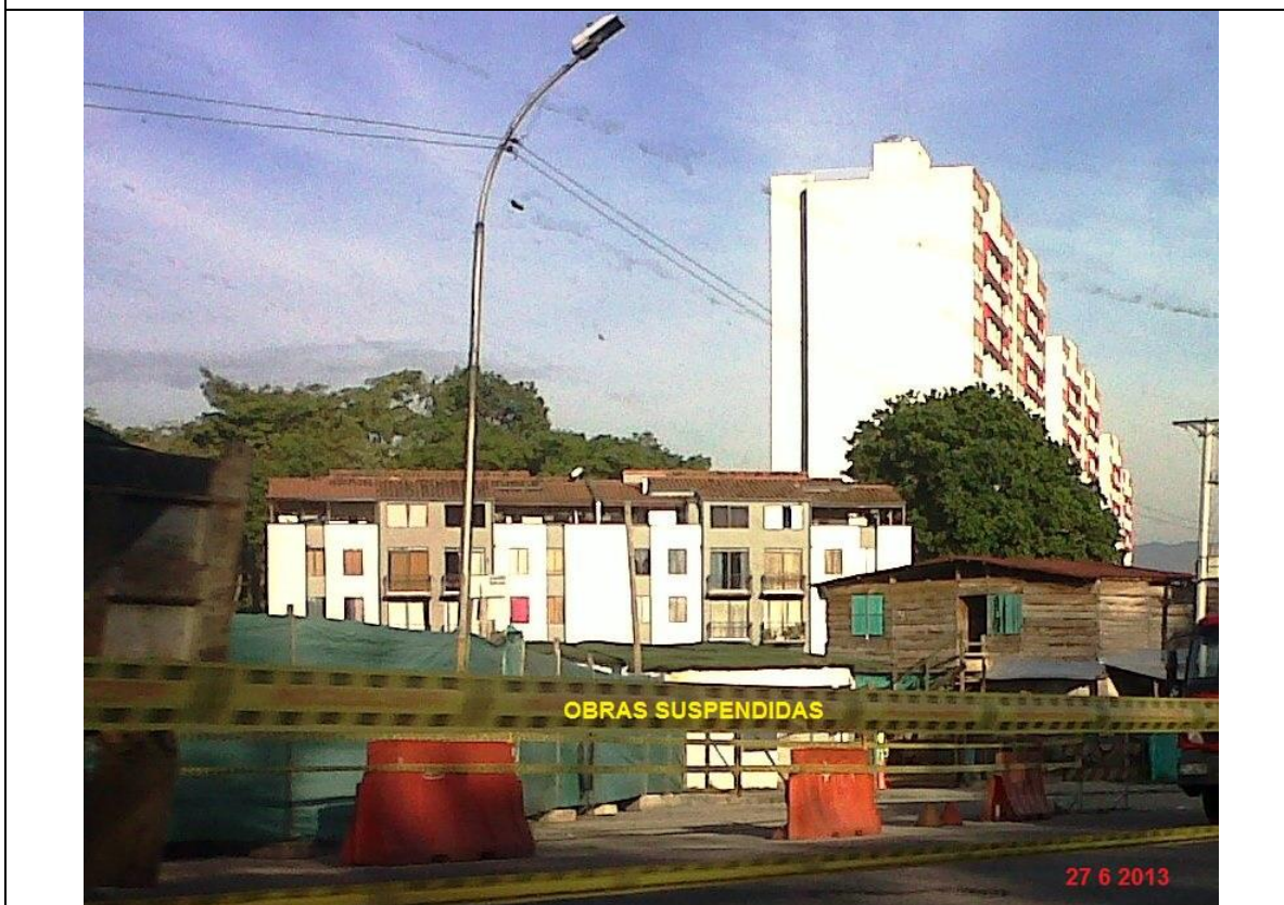
Figura 1 Estado de las obras de PQP
