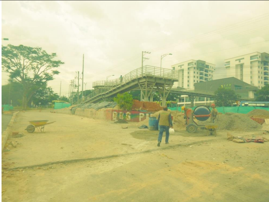
Foto 2. Obras de la Construcción Estación Temprana de Piedecuesta.
