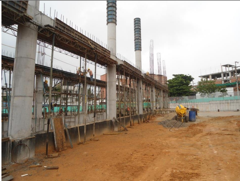
Figura 5 Avance Obras Portal Estación UIS
