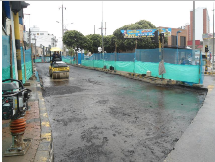
Figura 7. Obras Pretronal Carrera 17
