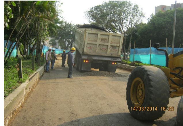
TRABAJOS PARA PAVIEMENTAR
