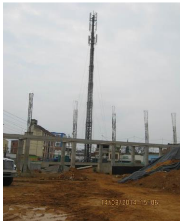
TORRE DE CLARO REINSTALADA PROVISIONALMENTE
