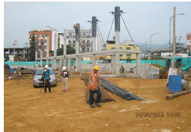
PLATAFORMA SUR EN CONSTRUCCIÓN OTRA VISTA
