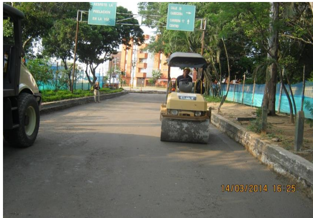
TRABAJOS PARA PAVIMENTAR
