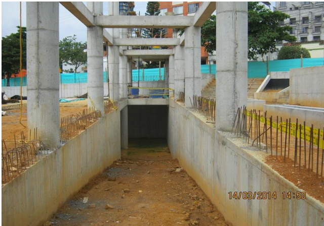
ACCESO AL TUNEL
