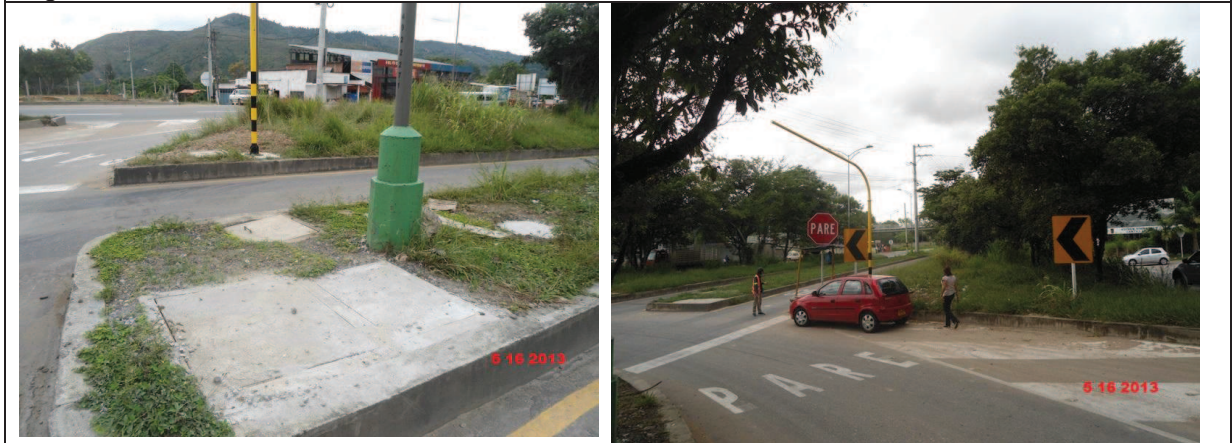
Figura 5. Obras de semaforización en retornos.
