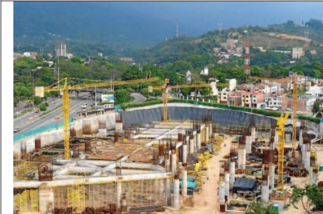
Figura 3. Estado de las obras de PQP
