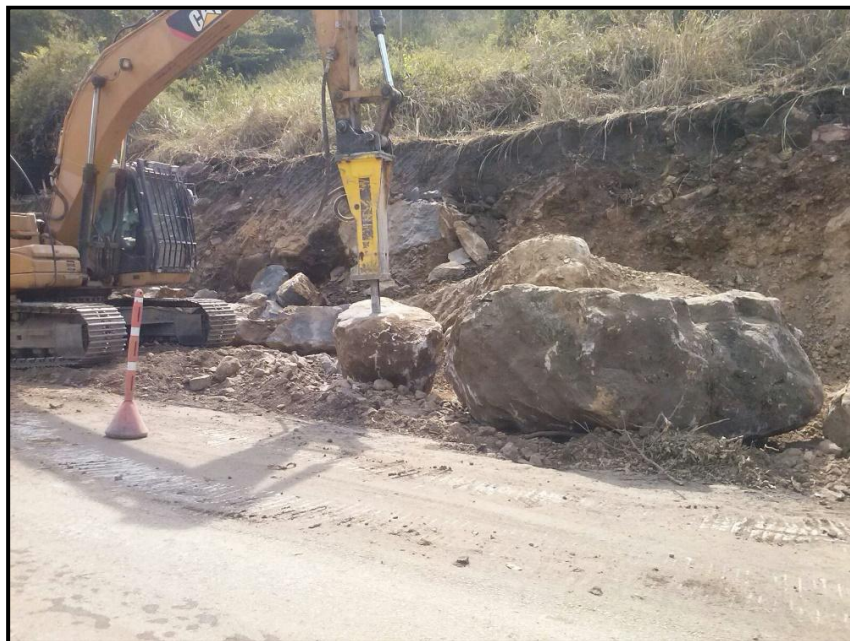
Excavación en Roca K 6+240
