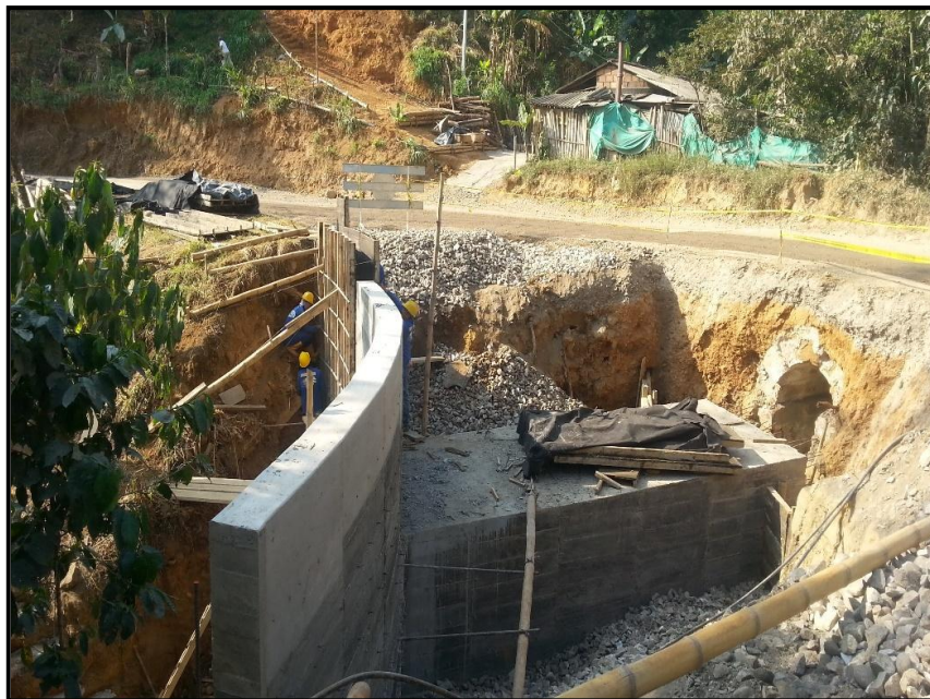
Estructura para Descole Box Coulvert K 29+640
