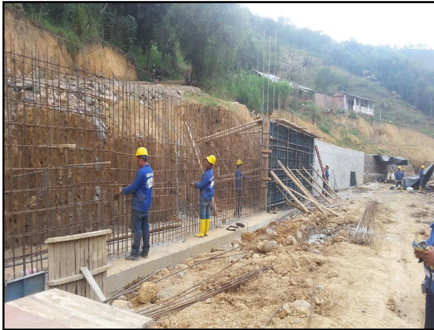
Amarre de Refuerzo para Vástago de Muro de Concreto K 28+300
