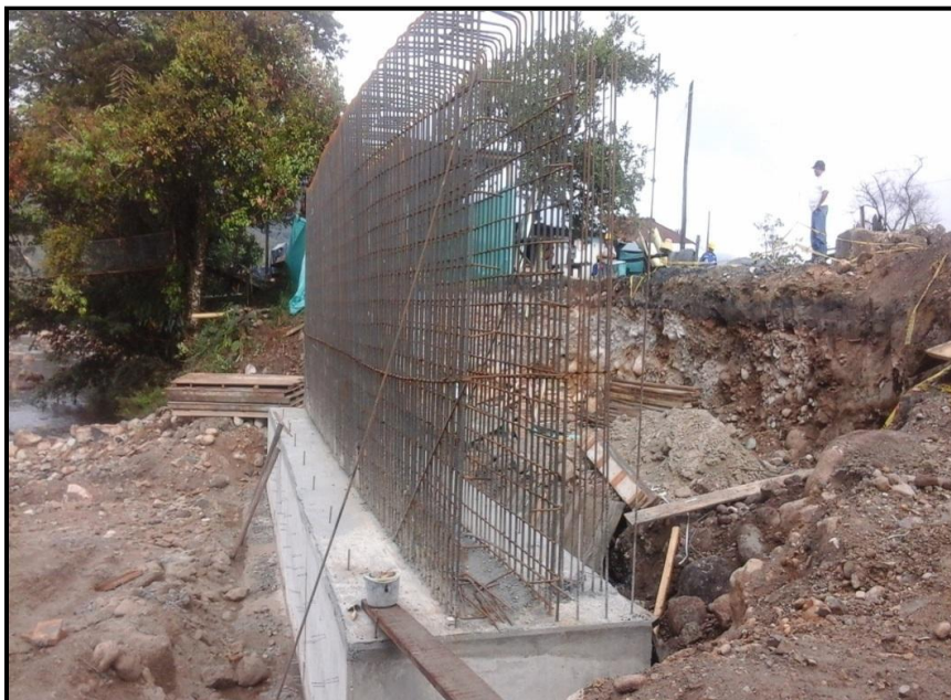
Zarpa Estribo Derecho Puente Violín K 62+500
