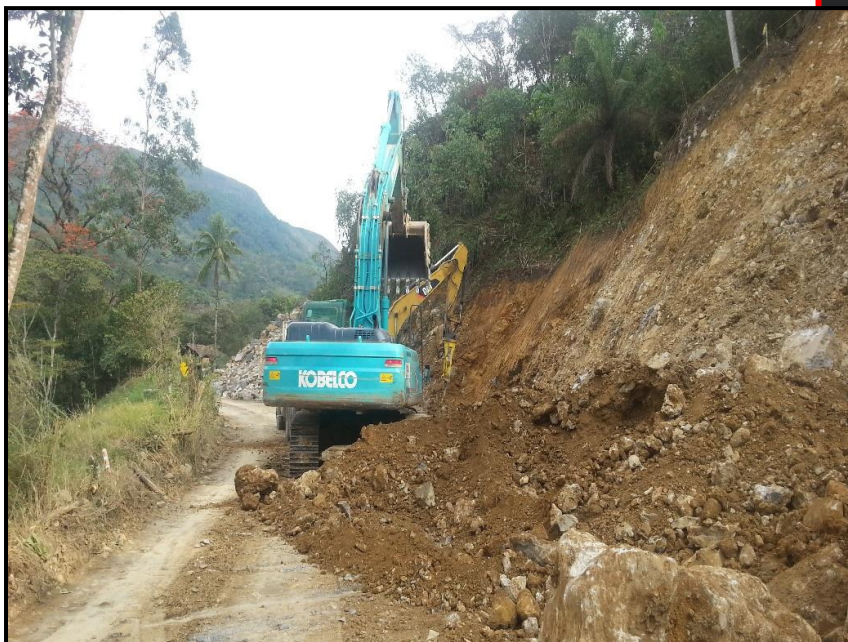
Demolición de Roca en Talud K 25+150
