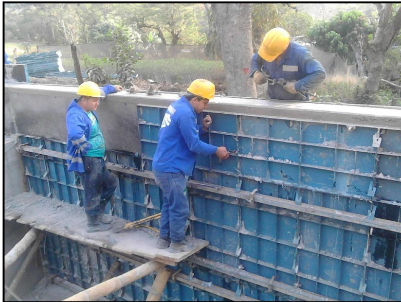
Desencofrado Muro de Box Coulvert K 5+250
