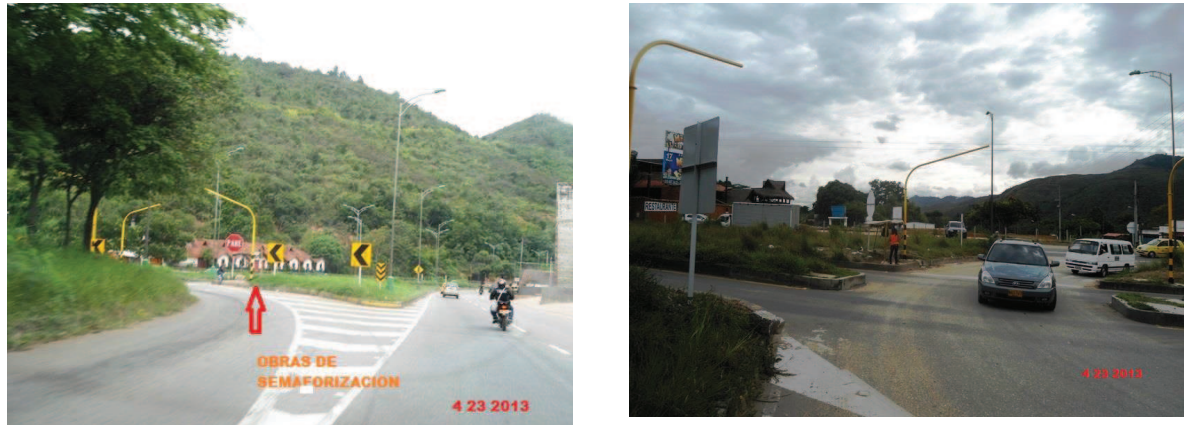
Figura 5. Obras de semaforización en retornos.
