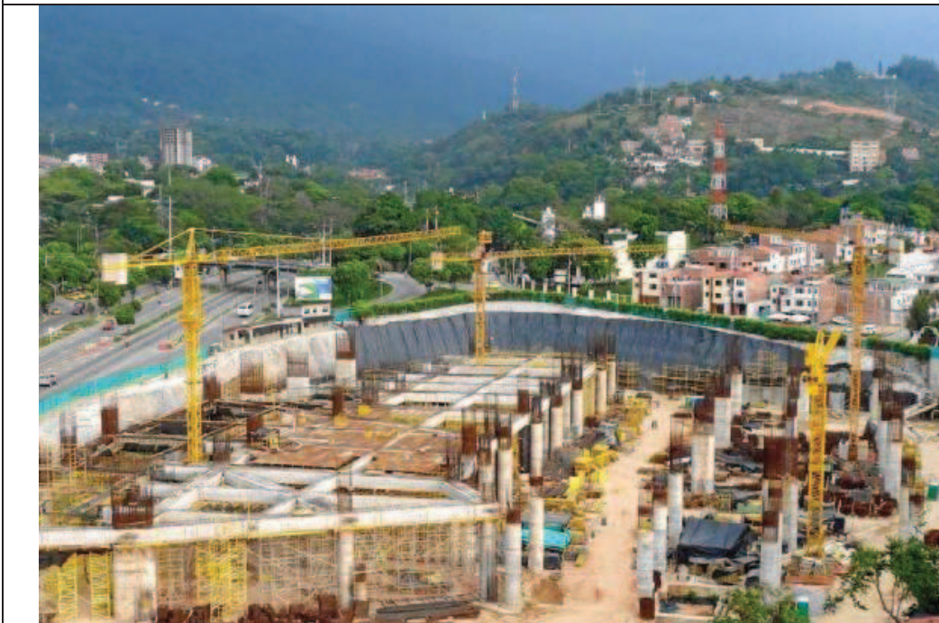
Figura 3. Estado de las obras de PQP
