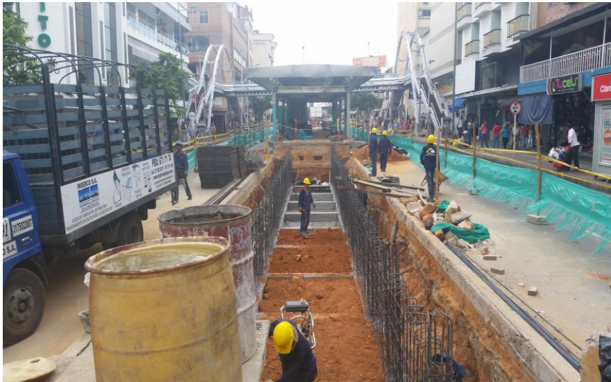
Foto No. 6 Inicio de Actividades Reubicación Estación Chorreras
