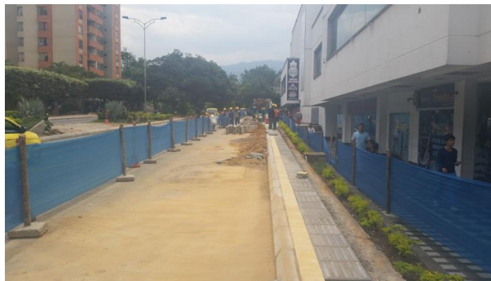
Foto 4. Obras Pretroncal Carrera 17 – Espacio Público
