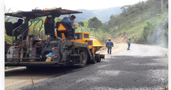
PR 37+730 Extendido de carpeta asfáltica
