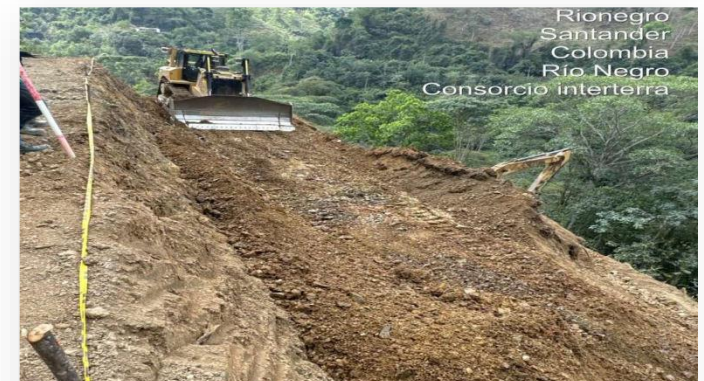
Excavación talud 2 terraza 2 k9+690 a 740
