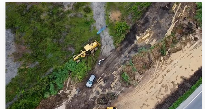
Inicio de Obra
