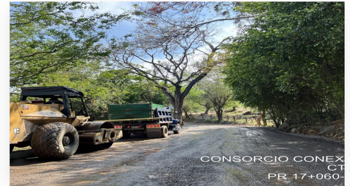
PR17+060 a PR17+125 Construcción estructura de pavimento (Tramo Galán – La Fuente)
