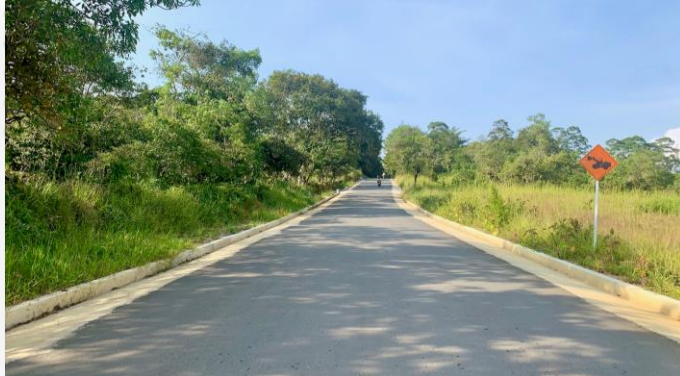
PR 52+190 a PR 47+022 (5,18 Km con pavimento y cunetas – Tramo Zapatoca – La Fuente)
