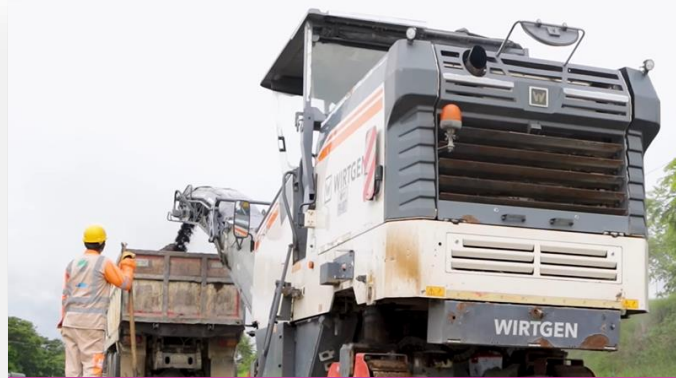
Obras de Mantenimiento
