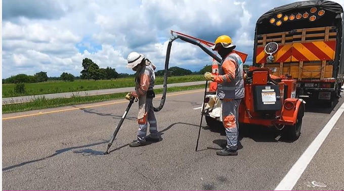
Obras de Mantenimiento
