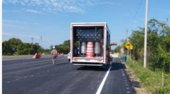
Obras de Mantenimiento
