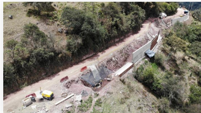
PR 12+260 Estabilización talud y muro de contención con cimentación profunda
