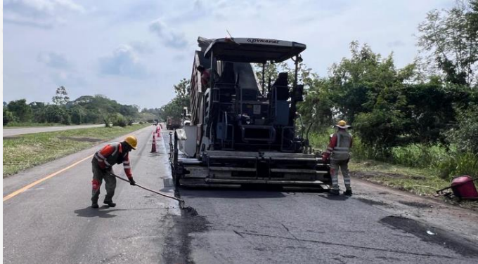
Obras de Mantenimiento
