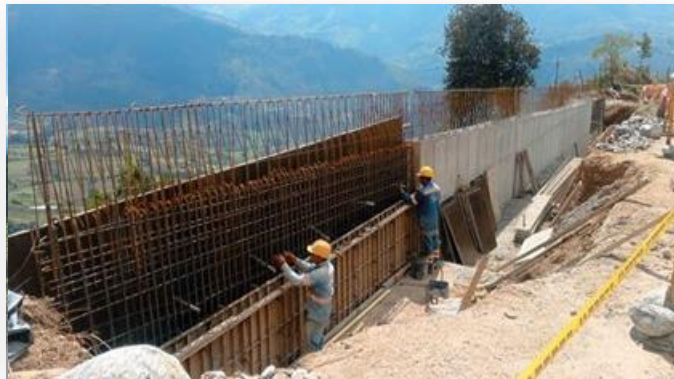
PR 68 Muro en construcción
