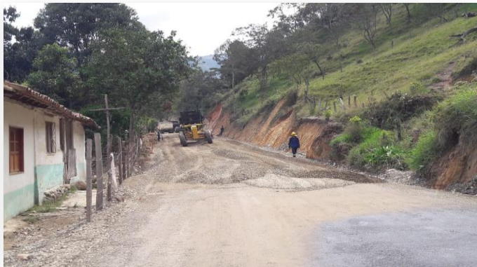
PR 38+030 – Extendido de base granular
