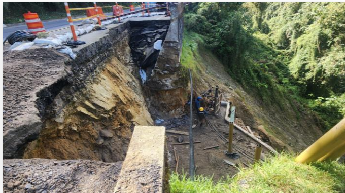
UF 2 Pr 33+150 const. de trinchos metálicos
