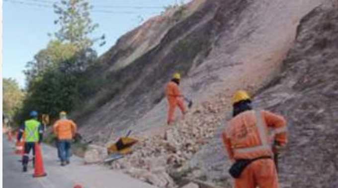
Remoción de derrumbes Tramo 3
