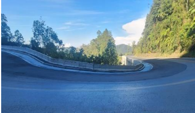
UF 2 Pr 30 Muro que estaba inconcluso
