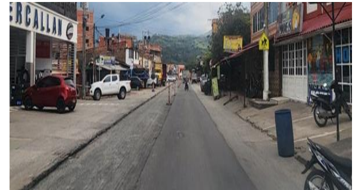
Mantenimiento variante Barbosa
