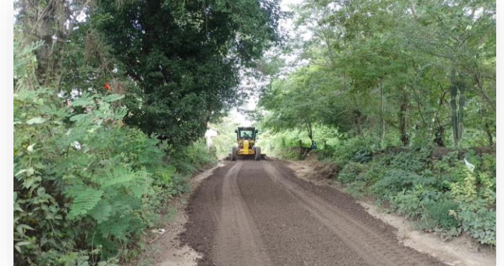
PR46+720 Aplicación capas granulares (Tramo Zapatoca – La Fuente)
