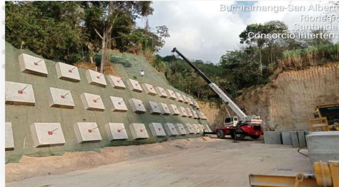
Instalación y tensionamiento dado anclajes k7+210
