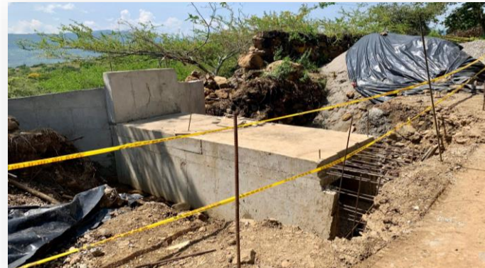
PR17+210 Construcción box culvert (Tramo Galán – La Fuente)
