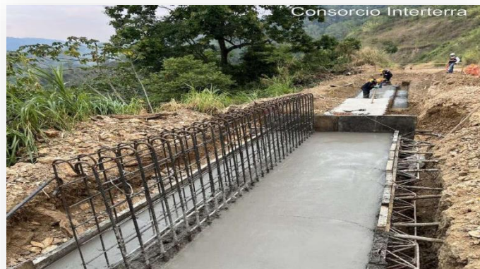
Construcción dentellón y zarpa muros superficial k7+700
