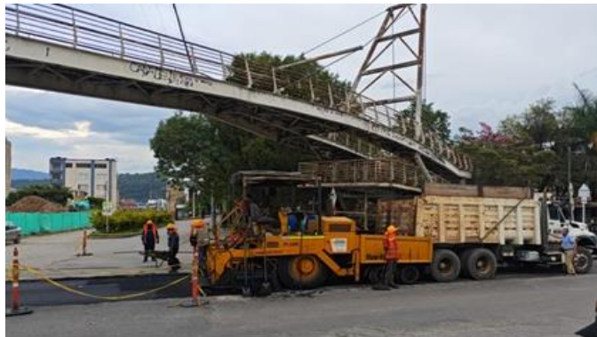
Mantenimiento variante Barbosa
