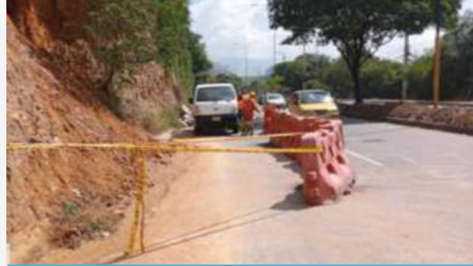
Remoción de derrumbe Tramo 10
