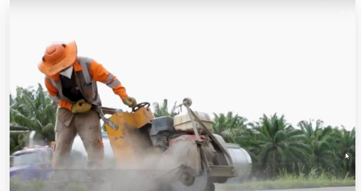
Obras de Mantenimiento
