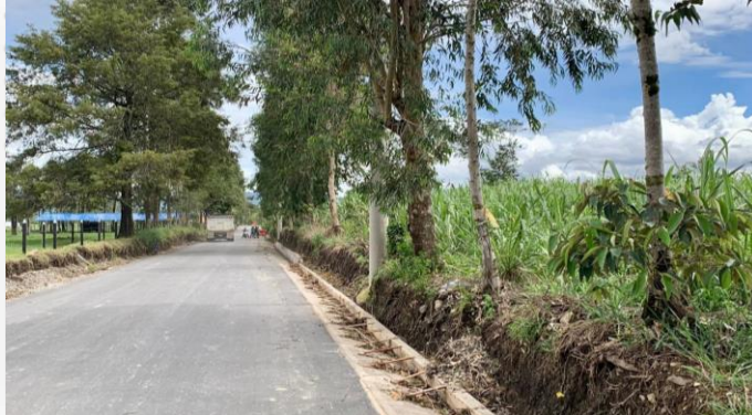
PR33+778 a PR37+600 Pavimento terminado
