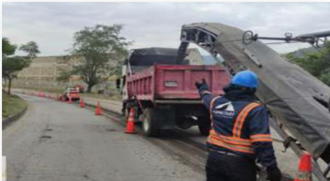
Fresado de Vía - Rehabilitación Tramo 4
