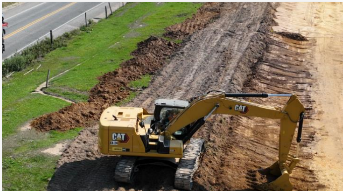
Inicio Obra nueva
