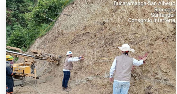
Construcción anclajes k9+710
