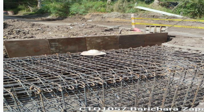
PR 45+795 Construcción box culvert (Tramo Zapatoca – La Fuente)
