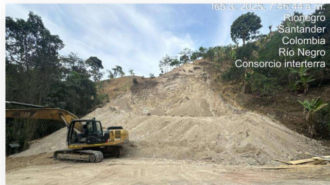
Excavación apoyo 2 puente Calera
