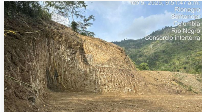
Excavación apoyo 2 puente Carpintera
