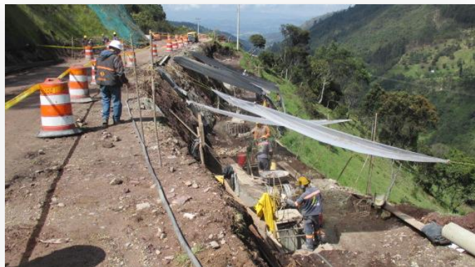
PR9+150 Construcción caisson para cimentación profunda de muro de contención
