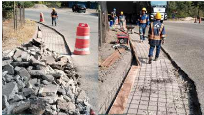
Fundida de cunetas Tramo 9
