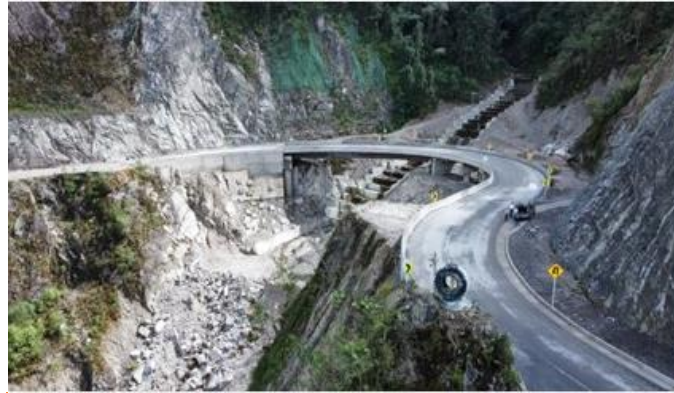
Pr 79 Puente la Judía terminado
