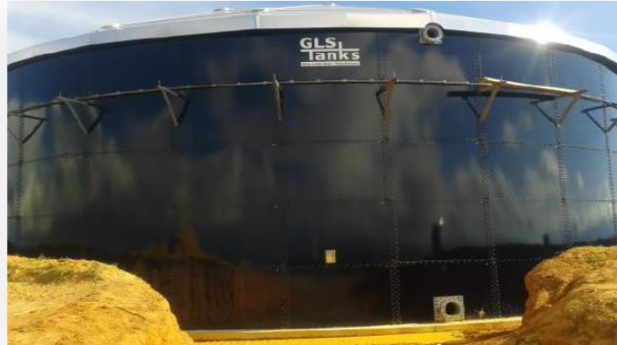
Tanques Almacenamiento de 2000 y 2500 m3 (2016)
