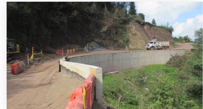
K12+730 Muros de contención con cimentación profunda
