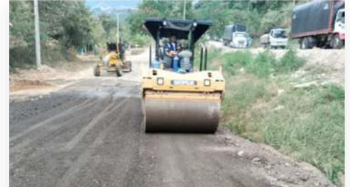
Compactación Material "Paso Malo"
