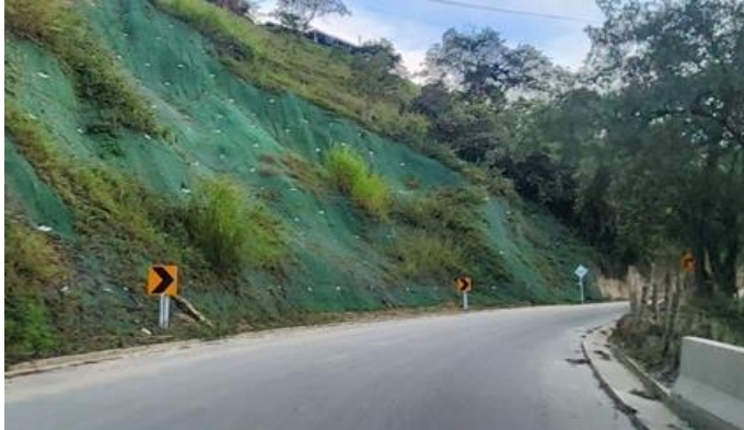
Pr 110 Taludes estabilizados
