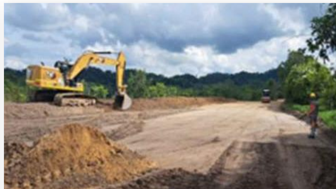
Inicio de Obra
