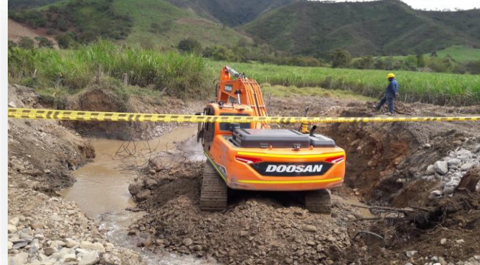
PR37+100 Construcción de box culvert
