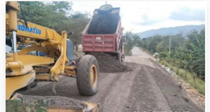
Conformación banca, fresado "Paso Malo"
