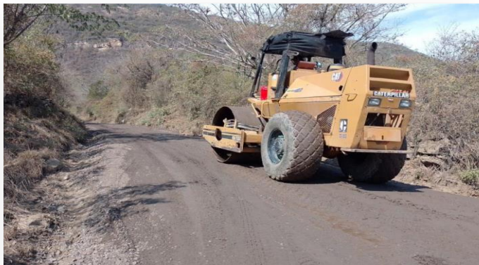
PR27+180 a PR 34+180 Mejoramiento de la vía con aplicación de material de afirmado
