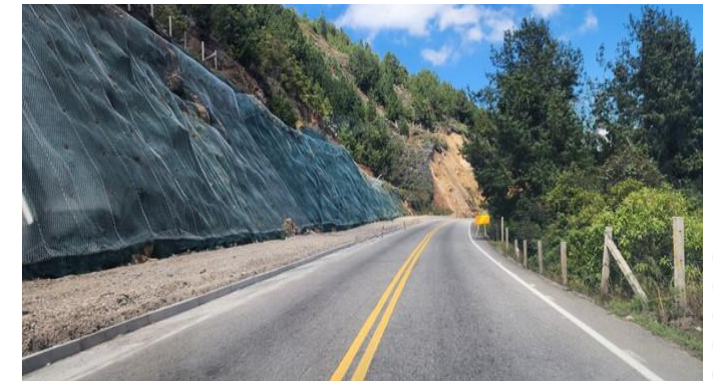
UF 4 Reparación taludes llegada a Pamplona
