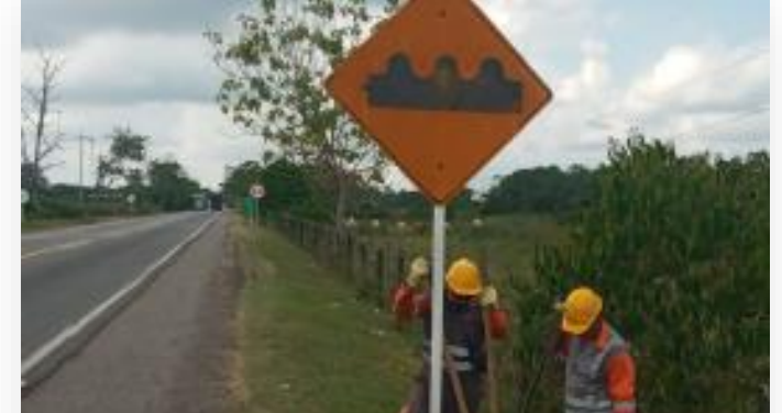
Obras de Mantenimiento
