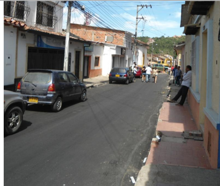
OBRAS DE REHABILITACION EN PIDEDUCUESTA
