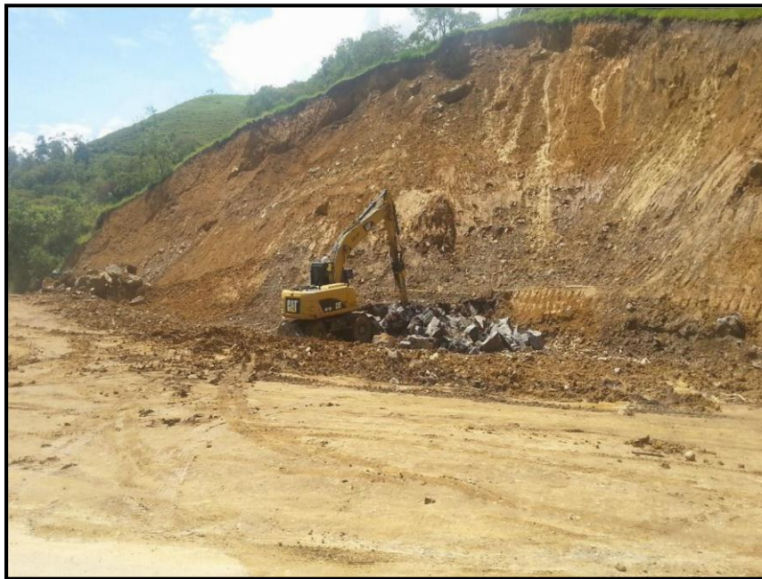
DEMOLICIÓN DE ROCA, K27+780
