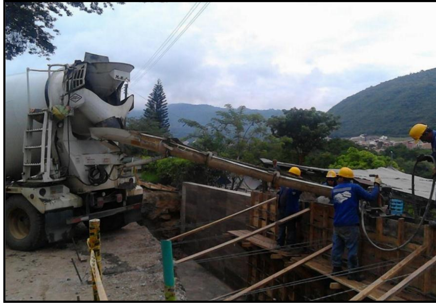
FUNDIDA ELEVACIONES MURO K1+ 670
