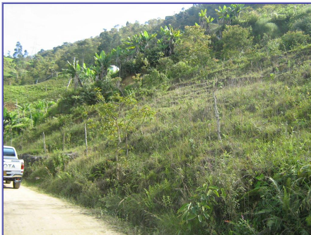
Foto 8. Zona de deslizamiento.
