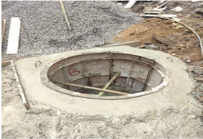
Pr 60 Cimentación para muros
