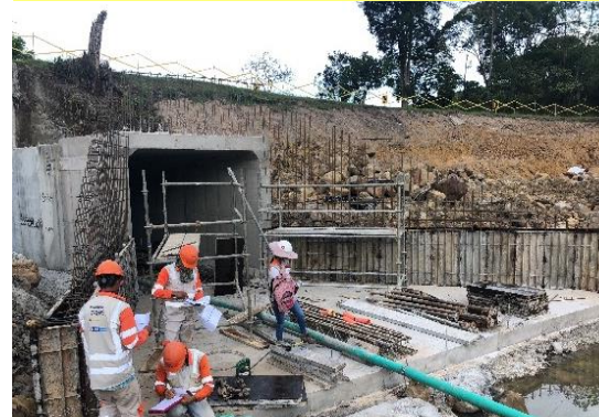
UF 9-CONFORMACION TERRAPLEN
