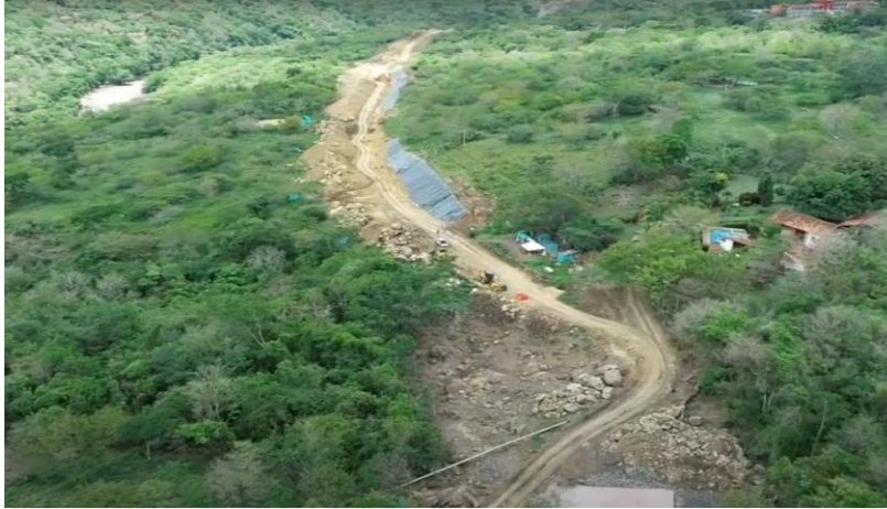
Avance explanación 2 km
