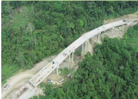
UF 5 – CONSTRUCCION VIADUCTO II
