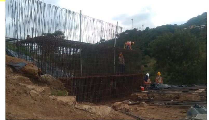
Pr 2+500 Cimentación Puente rio Fonce L= 360 m
