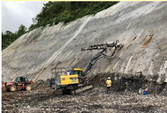
UF 8 – PROTECCION TALUDES
