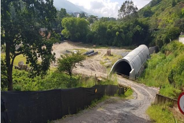
Uf 1 – Box culvert Mensuly
