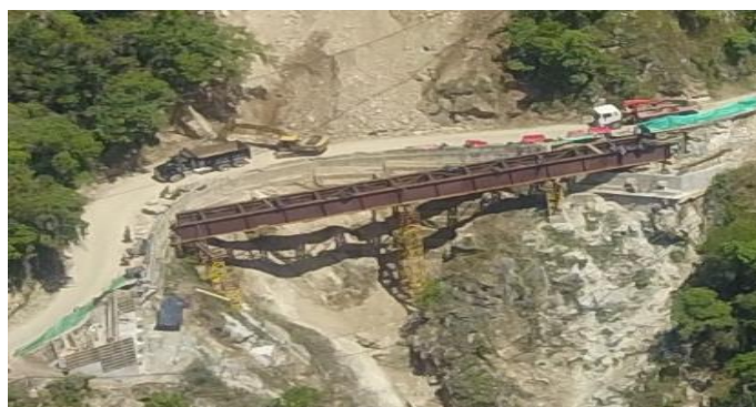
Pr 121 Puente en construcción
