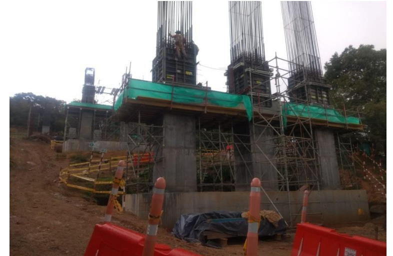
Pr 4 Cimentación Viaducto las Lajas L= 435 m
