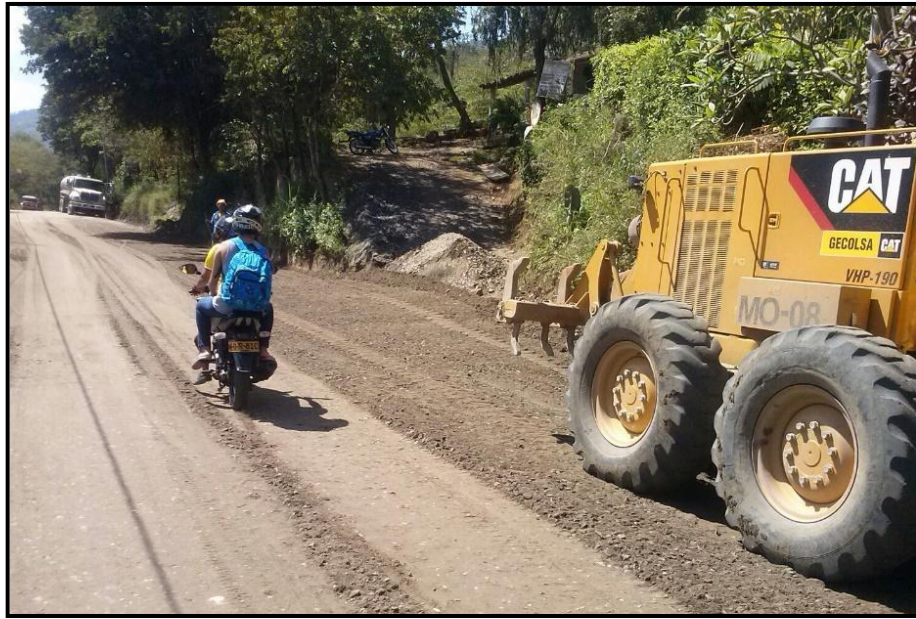
INSTALACIÓN DE BASE GRANULAR K3+ 010
