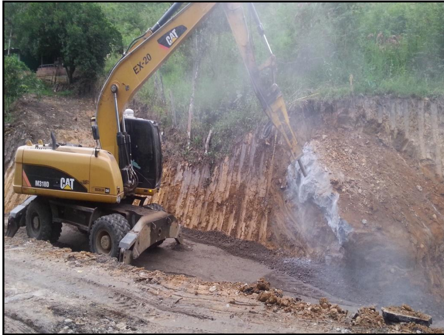
DEMOLICIÓN EN ROCA EN TALUD K25+ 380
