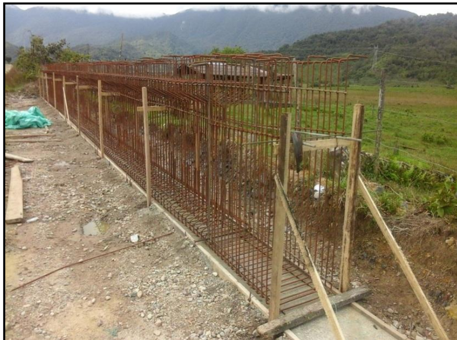
REFUERZO VIGAS SUPERESTRUCTURA PUENTE RIO VIROLÍN K61+500
