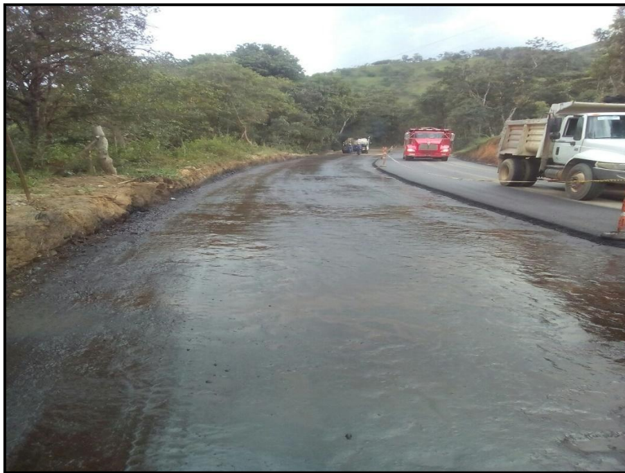
IMPRIMACIÓN CON EMULSIÓN ASFALTICA K26+400
