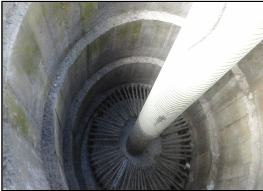
FUNDIDA PILOTE No. 6 PUENTE RIO VIROLÍN K61+500
