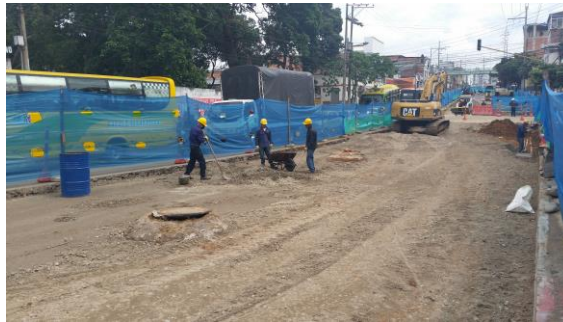
Foto 4. Obras Pretroncal Carrera 17
