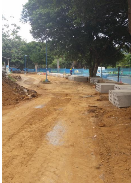
Foto 5. Obras Pretroncal Carrera 17 – Espacio Público
