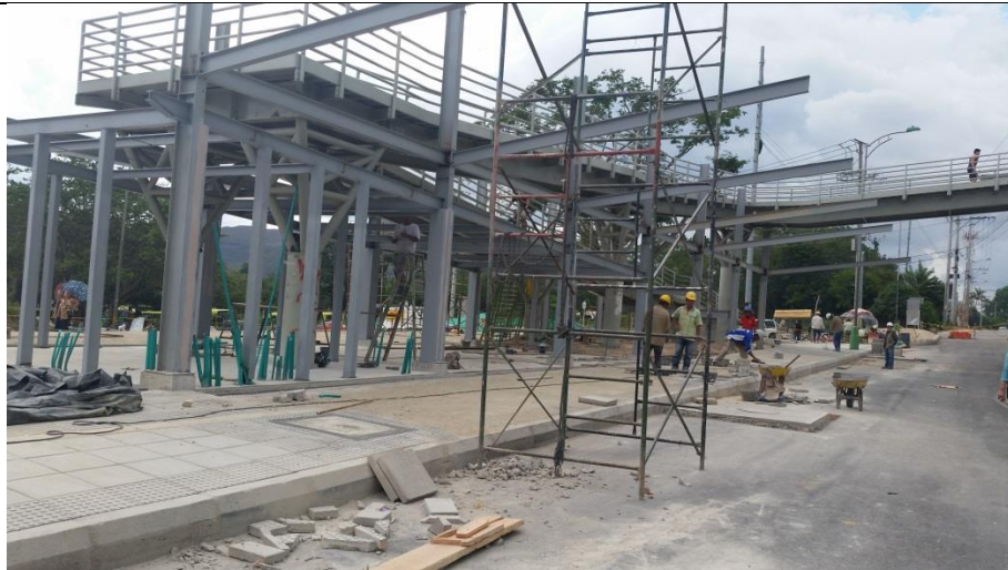
Foto 1. Obras de la Construcción Estación Temprana de Piedecuesta.
