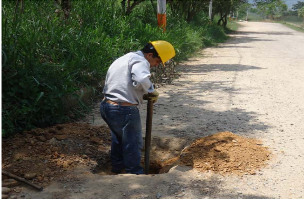
Figura 11 Localización y ejecución del apique 1
