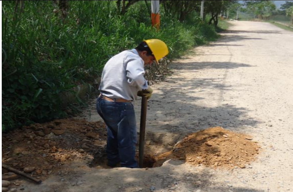
Figura 2 Localización y ejecución del apique 1
