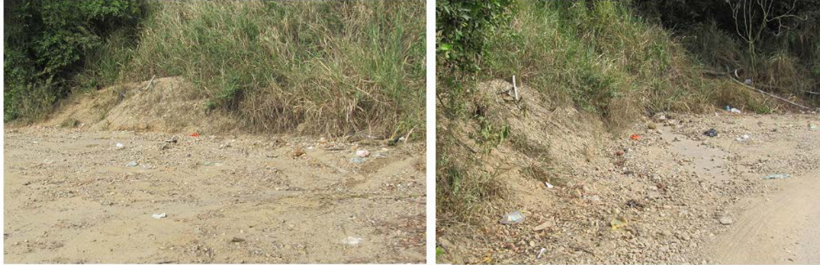
Figura 6 Zona con necesidad de limpieza y construcción del muro.
