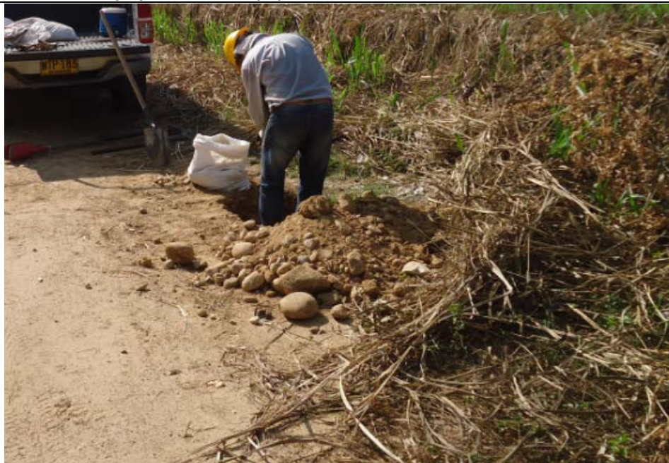
Figura 12 Localización y ejecución del apique 2
