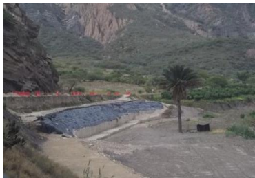
SOBRE EL K9. SE OBSERVA EL MURO EN CONCRETO Y TIERRA ARMADA CONSTRUIDO, CON EL FIN DE CONTROLAR LA SOCAVACION DEL CAUCE
