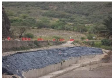
SOBRE EL K9. SE OBSERVA EL MURO EN CONCRETO Y TIERRA ARMADA CONSTRUIDO, CON EL FIN DE CONTROLAR LA SOCAVACION DEL CAUCE
