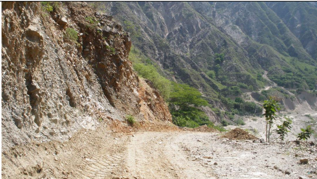
Figura 11 Tramo carreteable - primer kilómetro del proyecto.
