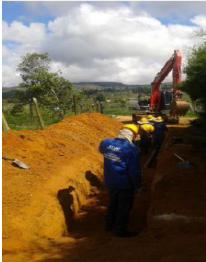
Instalación tubería HD
