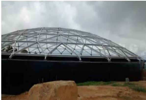
Tanque de Almacenamiento 2600m3
