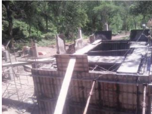
Construcción tanques de almacenamiento y casetas de bombeo (6)
