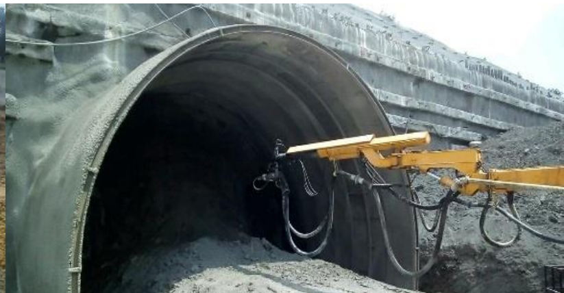
CONSTRUCCION PORTAL SALIDA TUNEL LA SORDA – UF 7
