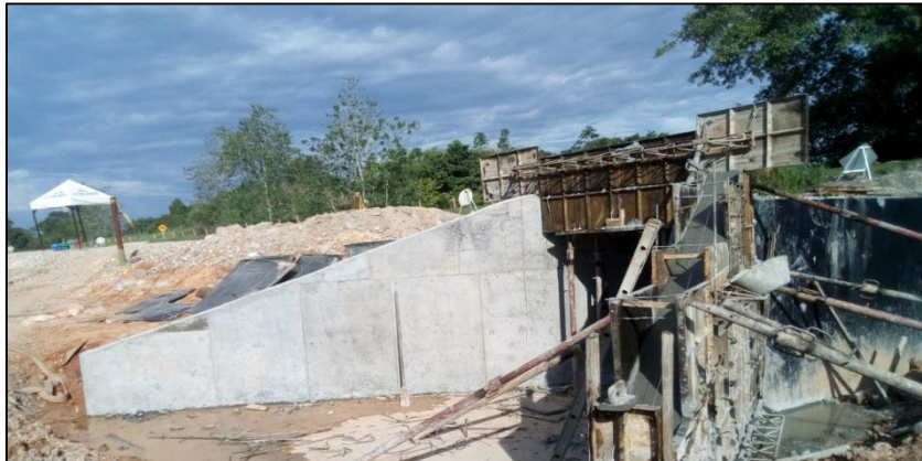
CONSTRUCCION OBRAS DE DRENAJE – UF 2,3
