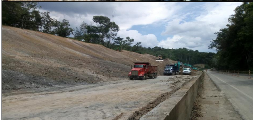
PERFILACION DE TALUD - CONFORMACION DE TERRAPLEN – UF 4
