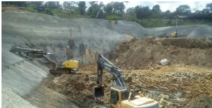
CONSTRUCCION PORTAL ENTRADA TUNEL LA SORDA – UF 7
