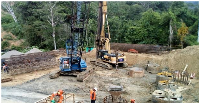
CONSTRUCCION VIADUCTO LA PELIGROSA – UF 5
