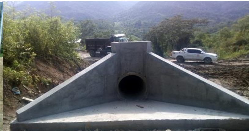
CONSTRUCCION OBRAS DE DRENAJE – UF 5
