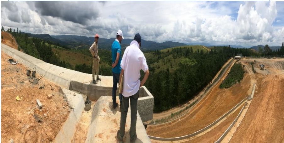
CONSTRUCCION OBRAS HIDRAULICAS
