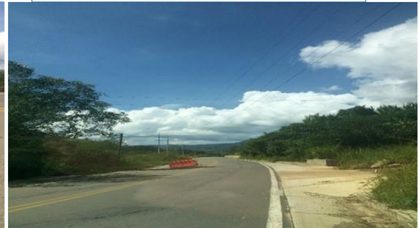
K10+495 HUNDIMIENTO VIACALZADA IZQUIERDA
