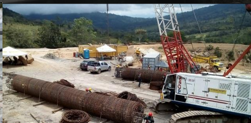
CONSTRUCCION PORTAL SALIDA TUNEL LA PAZ – UF 6
