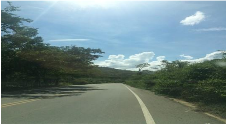
K5+320 ROCERIA LIMPIEZA DE CUNETAS
