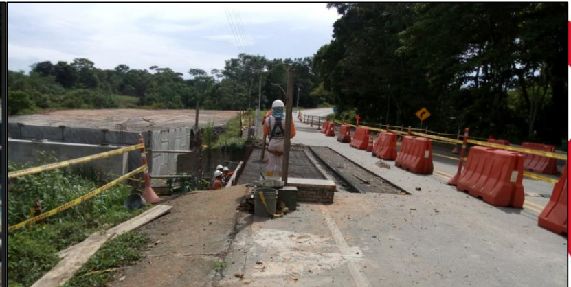
REPOTENCIACION PUENTE SANTA HELENA – UF 3
