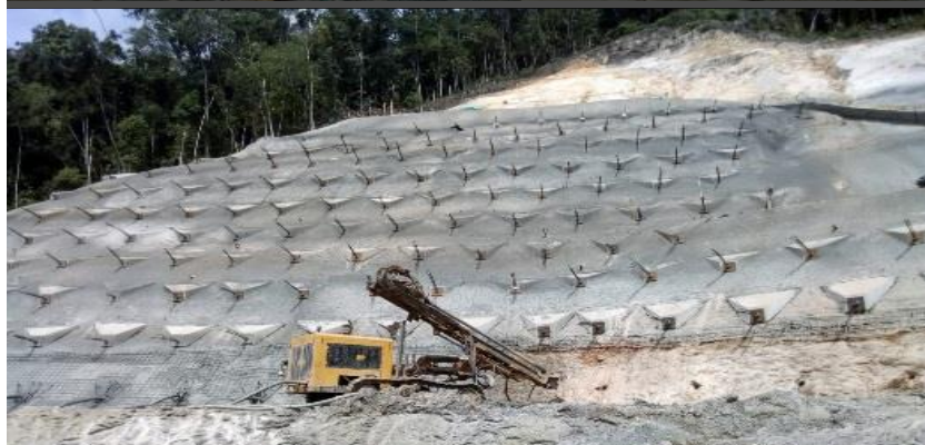
CONSTRUCCION PORTAL ENTRADA TUNEL LA PAZ – UF 6
