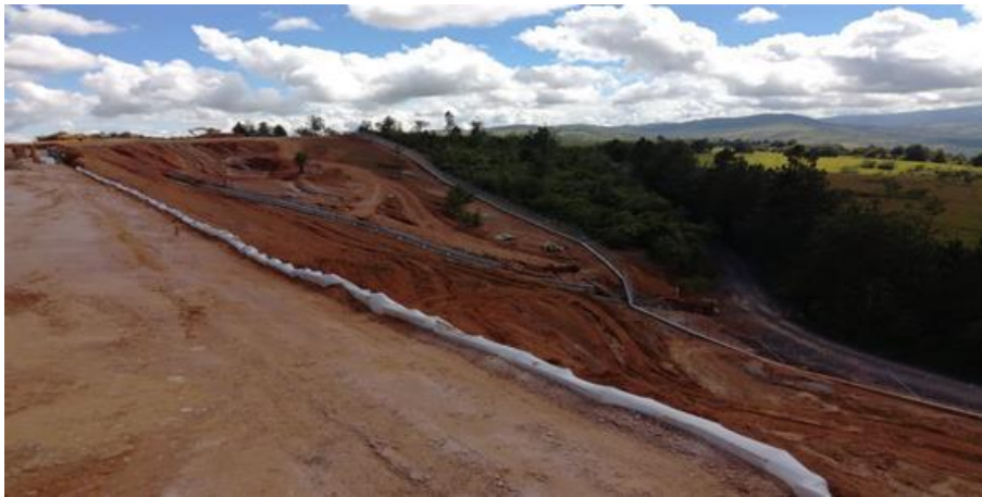
CONSTRUCCION OBRA HIDRAULICAS
