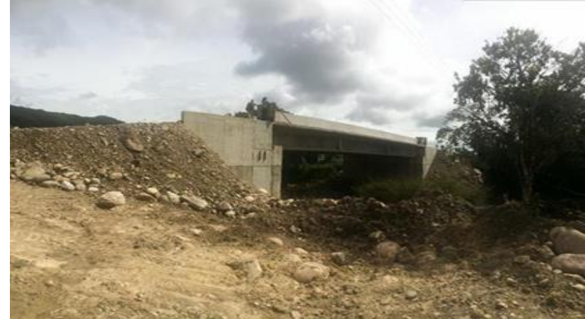
PRUEBA DE CARGA SOBRE EL PUENTE RIO VIROLIN Y RIO PIENTA
