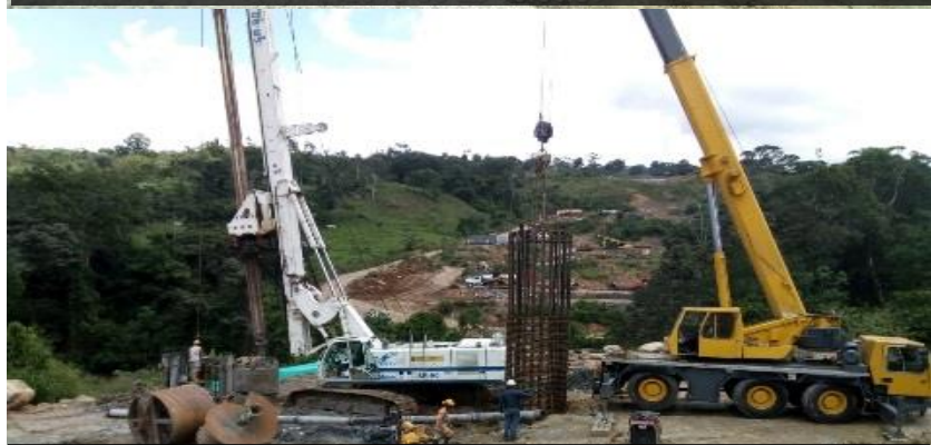
CONSTRUCCION VIADUCTO RIO SUCIO – UF 7
