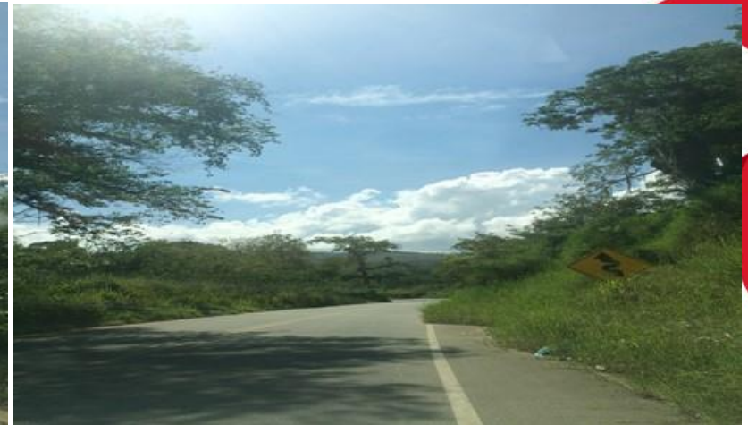
K7+060 LIMPIEZA DERRUMBE, ROCERIA Y LIMPIEZA CUNETAS
