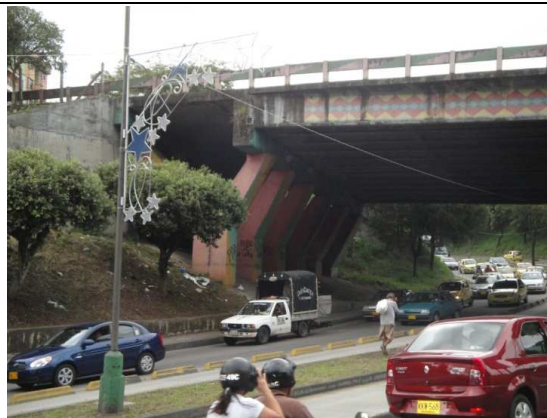
Figura 11 Estribo occidental puente conucos
