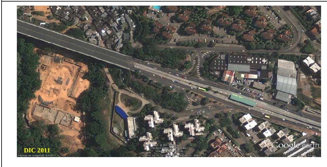
Figura 4. Autopista Floridablanca-Bucaramanga- Sector entrada al viaducto (3 carriles)
