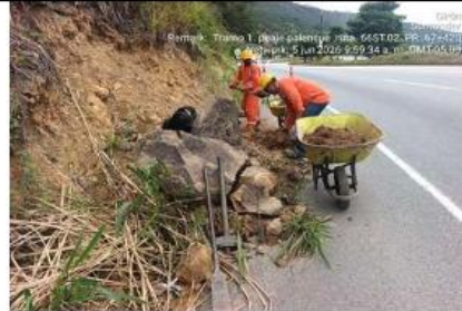
Limpieza de derrumbe menor PR 67+420 – Tramo 1.
