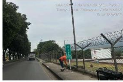
Instalación señal vertical PR 12+000 – Tramo 4.
