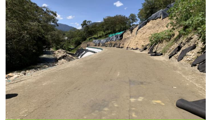
PR76+040. Muro en tierra armada
