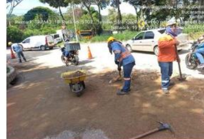
Limpieza de calzada en retorno El Bueno PR +160 – Tramo 7.
