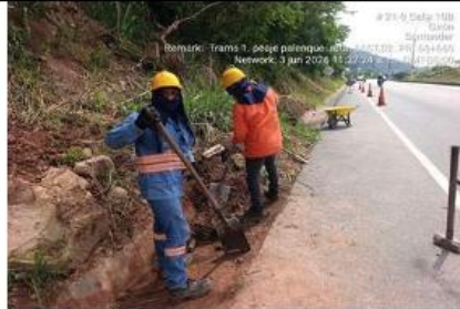
Limpieza de cunetas colmatadas PR 66+660 – Tramo 1.
