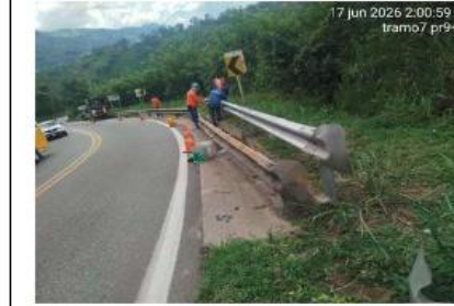
Reposición de defensas metálicas PR 9+530 – Tramo 7.
