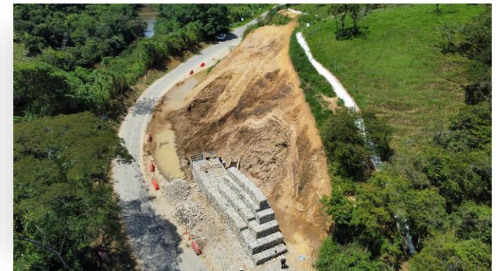
PR105+400 a PR105+800. Sitio crítico. Obras de Mitigación
