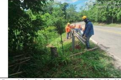
Reposición de defensas metálicas PR 13+500 – Tramo 9.
