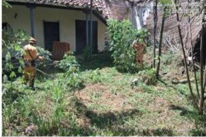
Rocería y desmonte CCO La Cemento PR 0+300 – Tramo 5.
