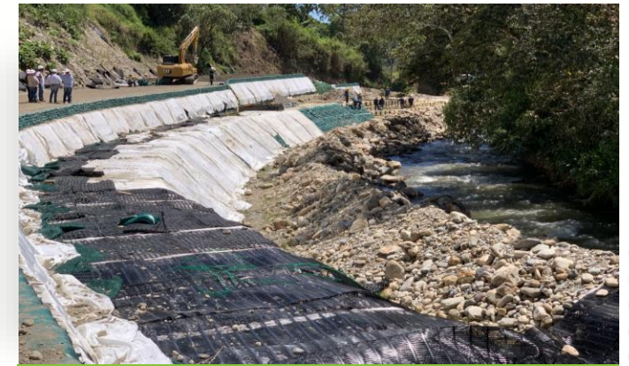
PR76+040. Obra de protección de orilla en hydroblocks y muro en tierra armada
