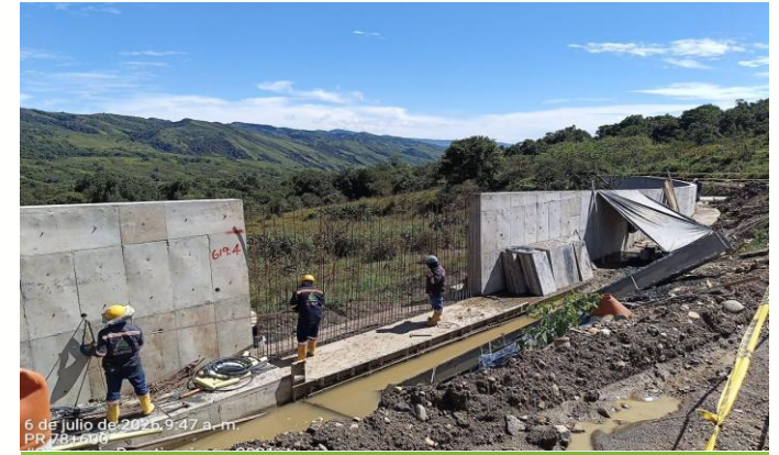
PR78+520 a PR78+722. Muro de contención Con cimentación profunda
