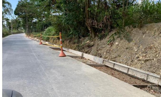
PR36+800. Construcción de cunetas
