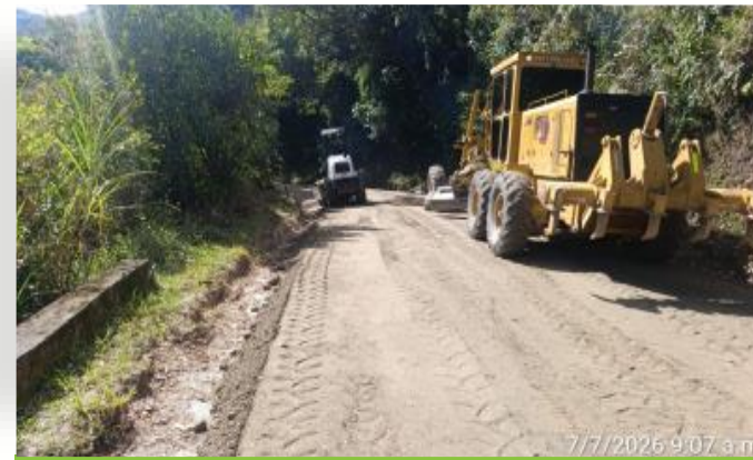
PR63+700. Conformación de la calzada (Sector Onzaga – San Joaquín)
