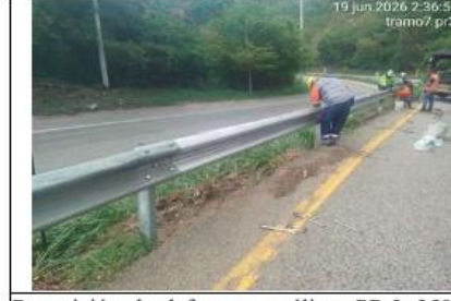
Reposición de defensas metálicas PR 3+350 – Tramo 7.
