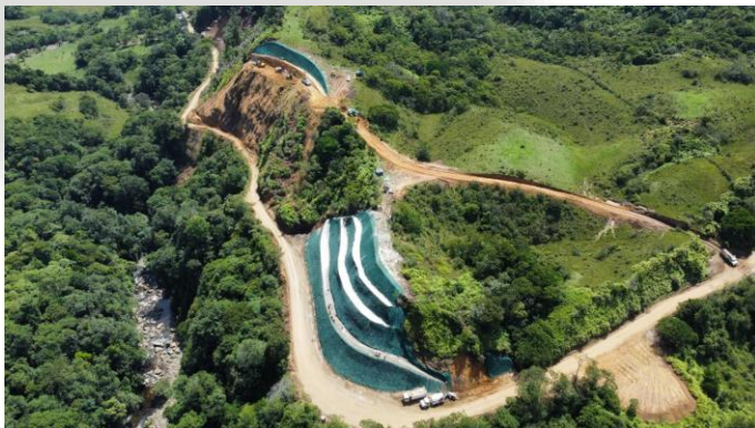
PR80+900 y PR81+100. Estabilización de taludes
