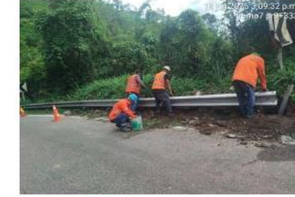
Reposición de defensas metálicas PR 9+333 – Tramo 7.
