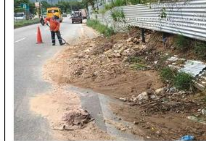
Limpieza de material de arrastre acumulado en PR 73+000 – Tramo 10.
