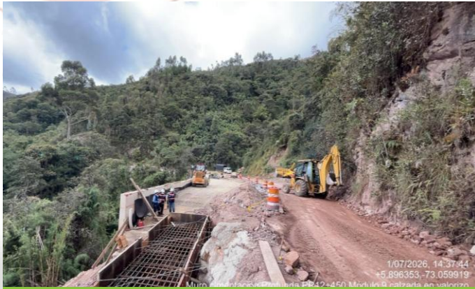
PR12+394 a PR12+577. Muro de contención Con cimentación profunda y viga en voladizo
