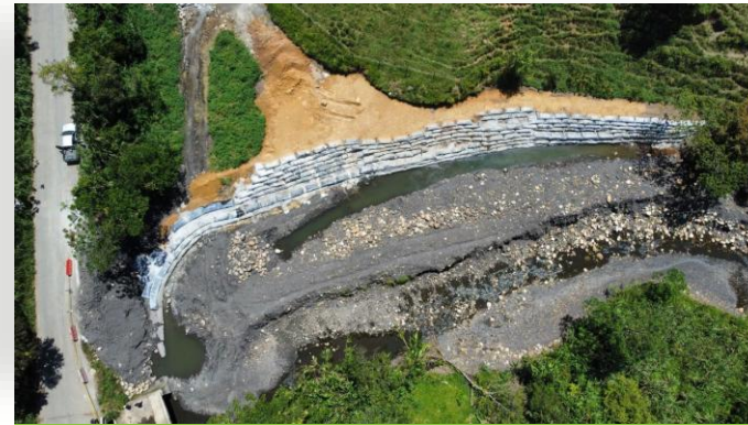
PR90+400. Sitio crítico La Morena. Obras de mitigación quebrada San Antonio
