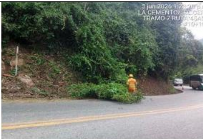
Corte y retiro de ramas caídas sobre la vía PR 10+100 – Tramo 7.
