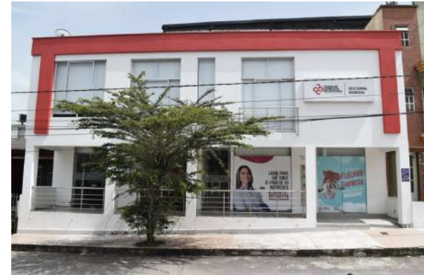
Remodelación de la oficina de Barbosa
