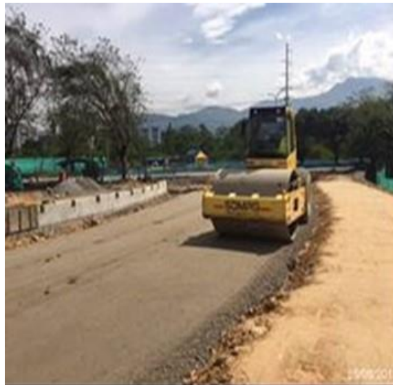
PR 3 + 000 – construcción terraplén instalación capas base granular
