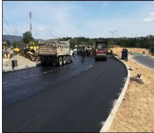
PR 3 + 000 - Eje 1 – Instalación mezcla modificada MDC-19 Tipo III
