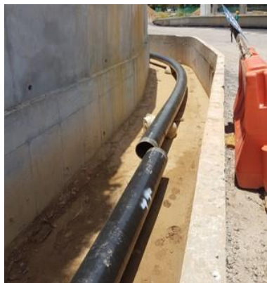
TENDIDO TUBERIA DE GAS SOBRE CARCAMO
