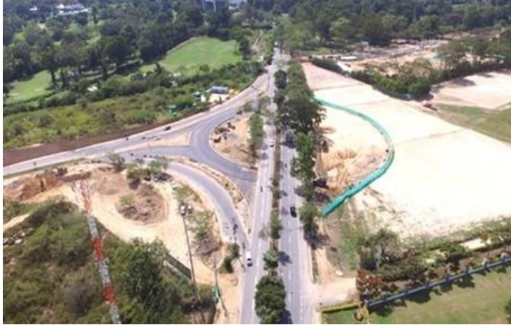
PR 3 + 000 – Avance general proyecto
