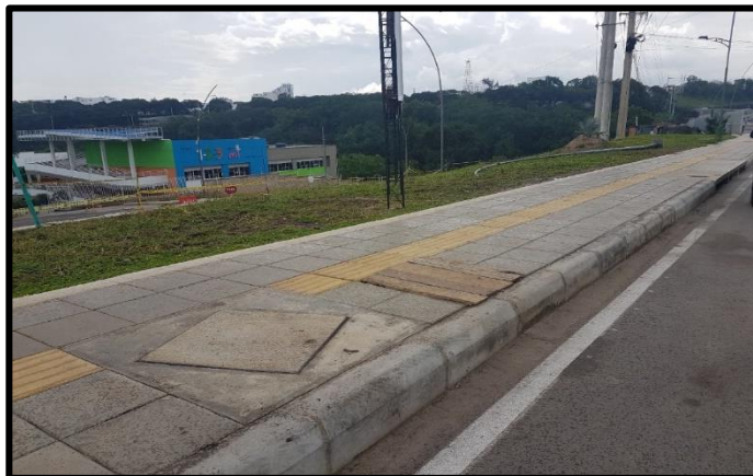
Pendiente instalación de tapas de cajas eléctricas
