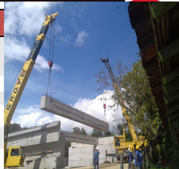
K52+000 IZADA VIGAS DE CONCRETO
