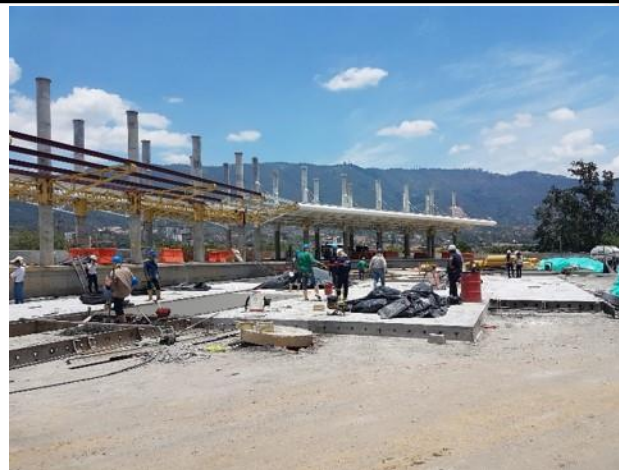
FUNDIDA DE LOSAS MR
