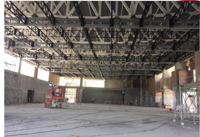
Instalación estructura metálica Gran Salón
