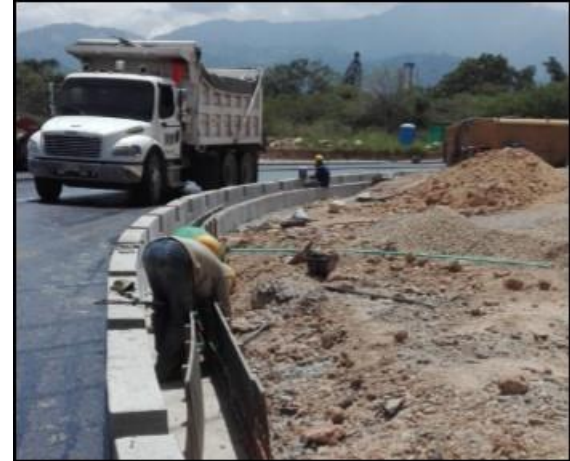
PR 3 + 000 - Eje 1 – Construcción canal perimetral Glorieta
