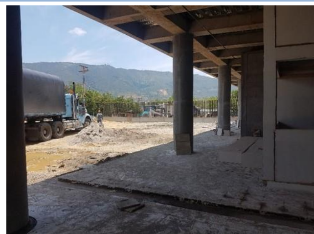
EXTERIORES EDIFICIO PORTAL
