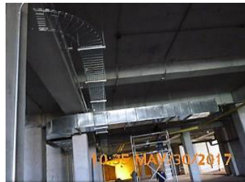
Instalación ductería eléctrica y de aire acondicionado
