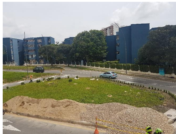
ARREGLOS ACCESO DEPRIMIDO BARRIO DIAMANTE II
