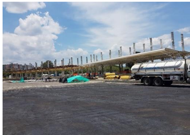
IMPRIMACION Y ASFALTADO
