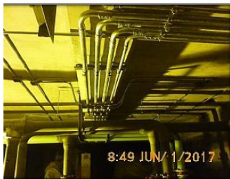
Instalación ductería eléctrica y de aire acondicionado
