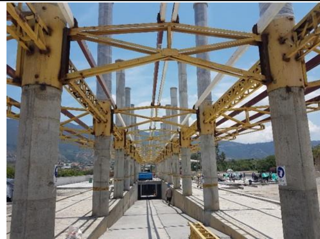
INSTALACION ESTRUCTURA DE PORTAL
