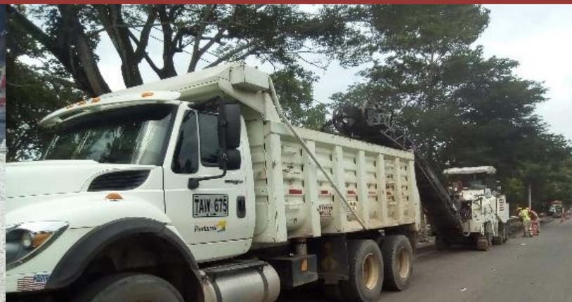
UF1 - FRESADO DE LA VIA PR 08+215
