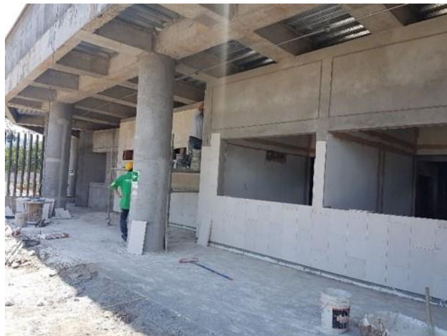
EXTERIORES EDIFICIO PORTAL
