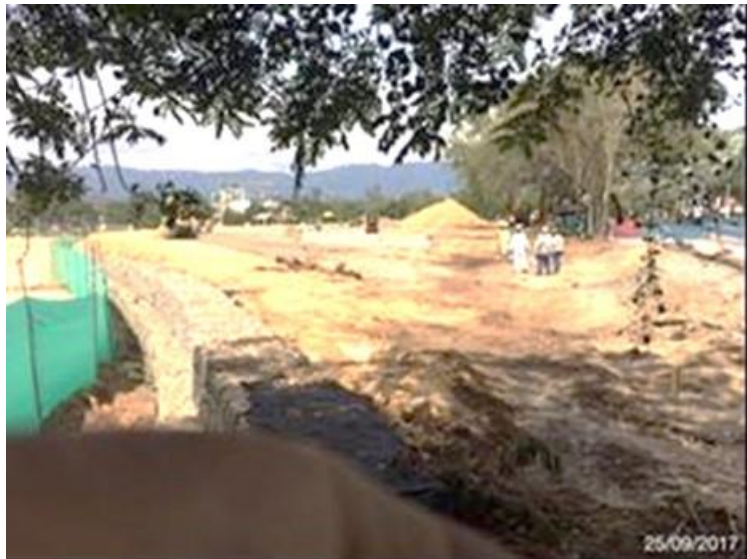
PR 3 + 000 - Construcción gaviones Predio Avidesa
