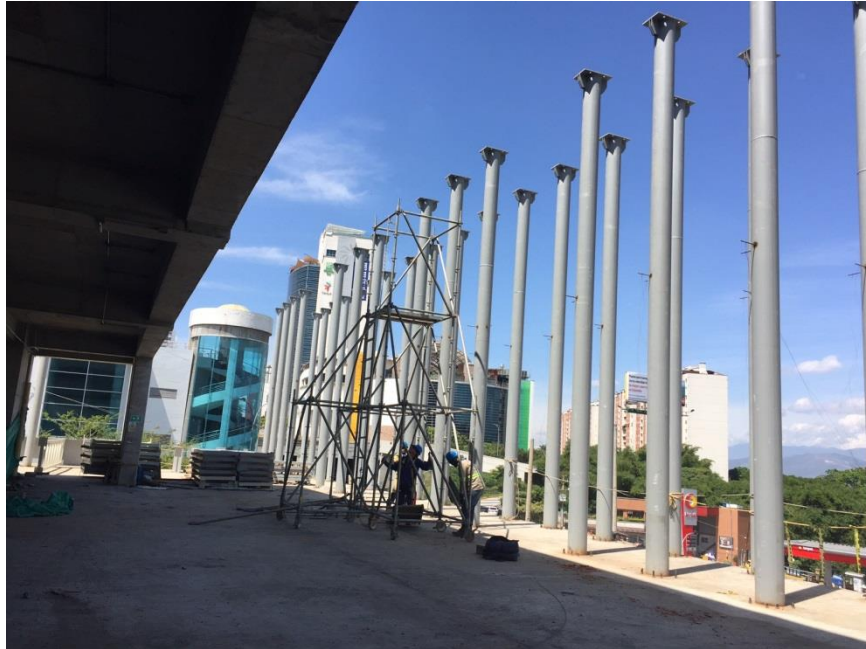
Instalación estructura metálica de la columnata
