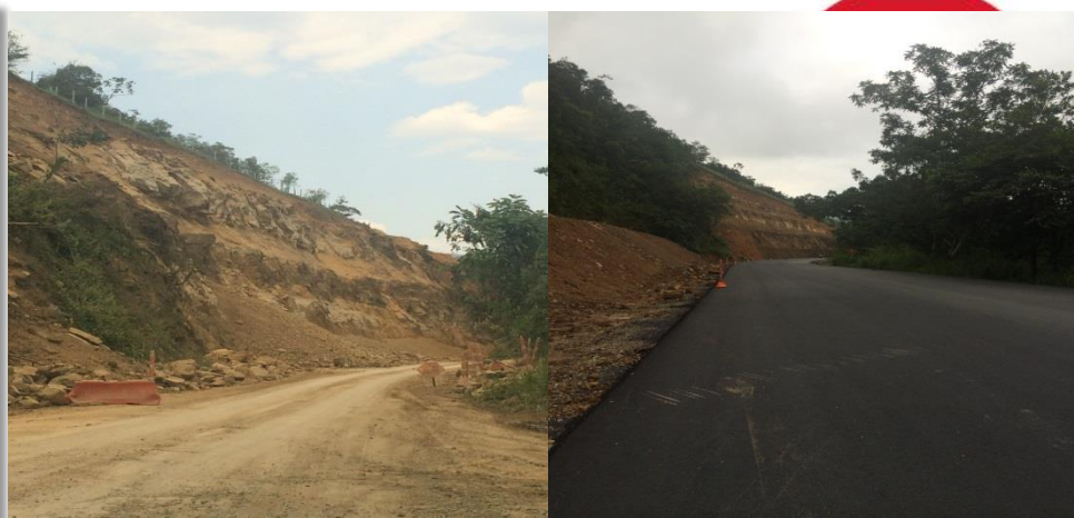
K16+530 ANTES Y DESPUES
