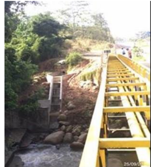
PR 3 + 000 - Construcción disipador entrega alc pluvial
