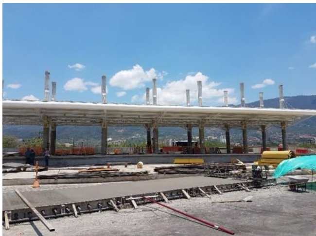
FUNDIDA DE LOSAS MR
