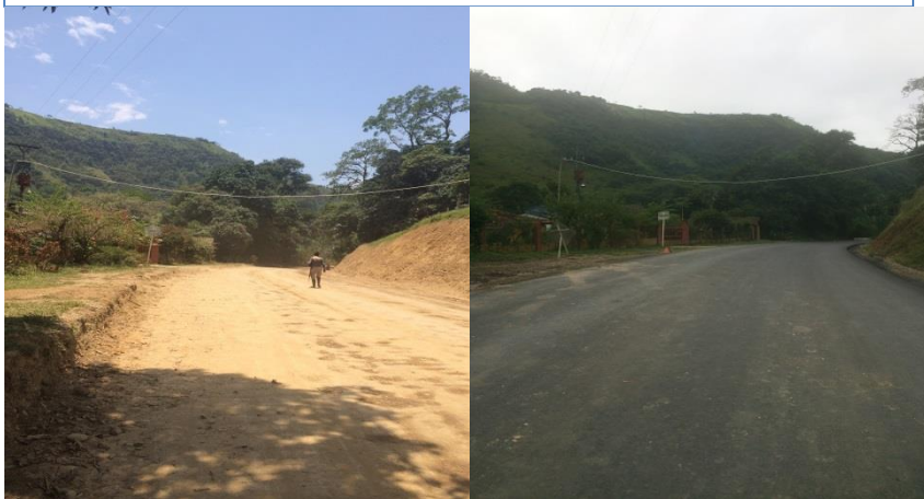
K32+120 ANTES Y DESPUES
