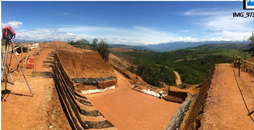
CONSTRUCCION MURO EN TIERRA ARMADA
