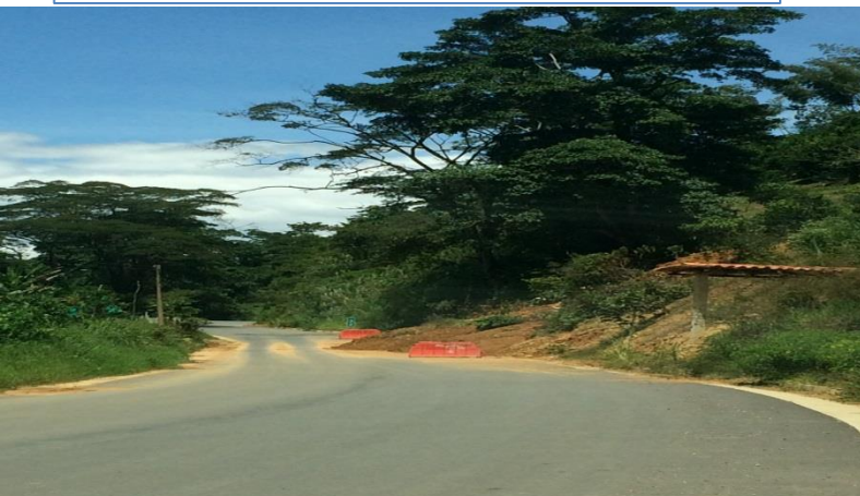
K31+500 LIMPIEZA DE DERRUMBE
