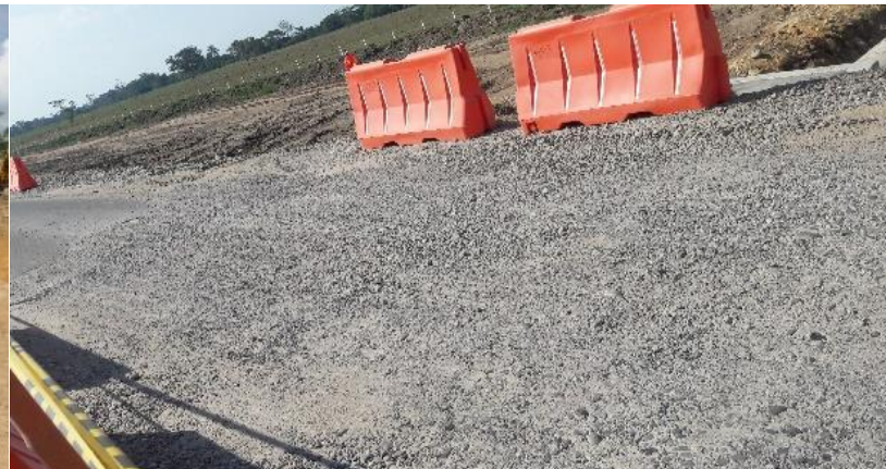
PR10+390 INSTALACIONES MATERIAL DE BASE – UF 3
