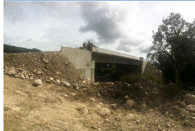
PRUEBA DE CARGA SOBRE EL PUENTE RIO VIROLIN
