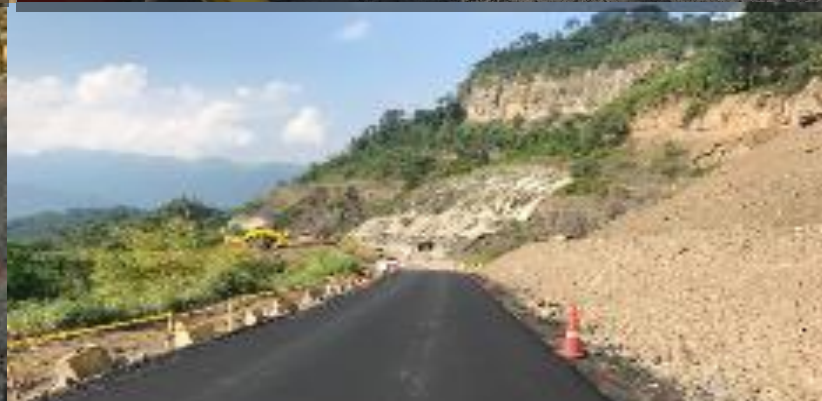
ESTRUCTURA EM PAVIMENTO EN EL PR 31+000 – UF 3,2
