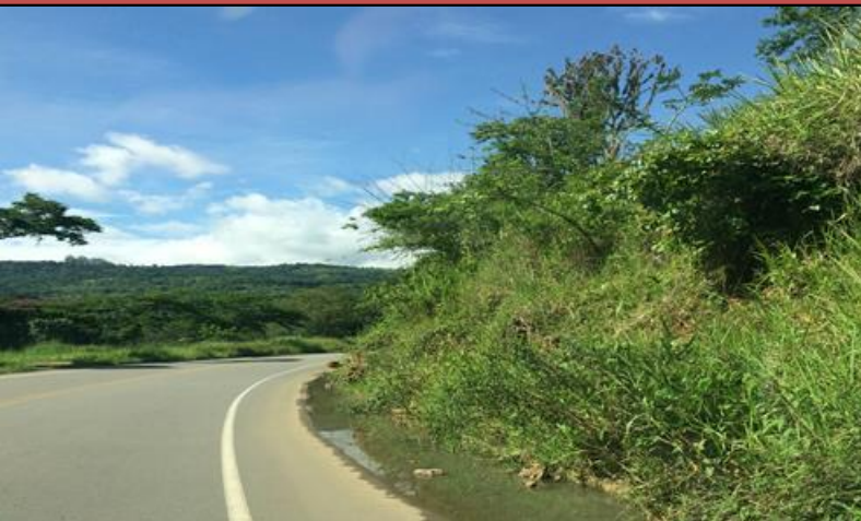
K7+835 LIMPIEZA DERRUMBE, ROCERIA Y LIMPIEZA CUNETAS
