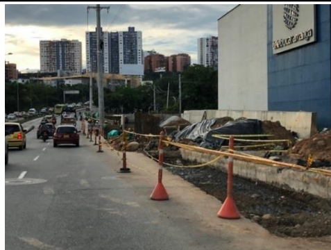
Sector del puente de Molinos
