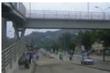
Girón. Sector calle 39 con carrera 18. No uso del puente peatonal
