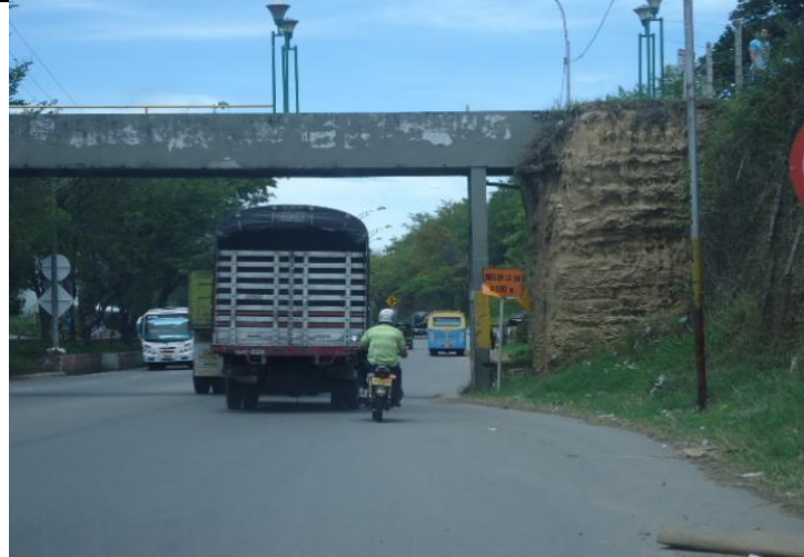
SIN SOLUCION PUENTES PEATONALES PASO POR PIEDECUETA.
