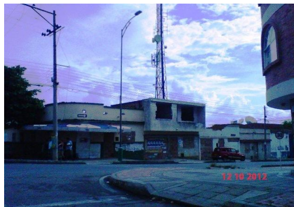
CONTINUA PROBLEMÁTICA TORRE TELEFONIA EN PREDIOS PARA LA ESTACION UIS.
